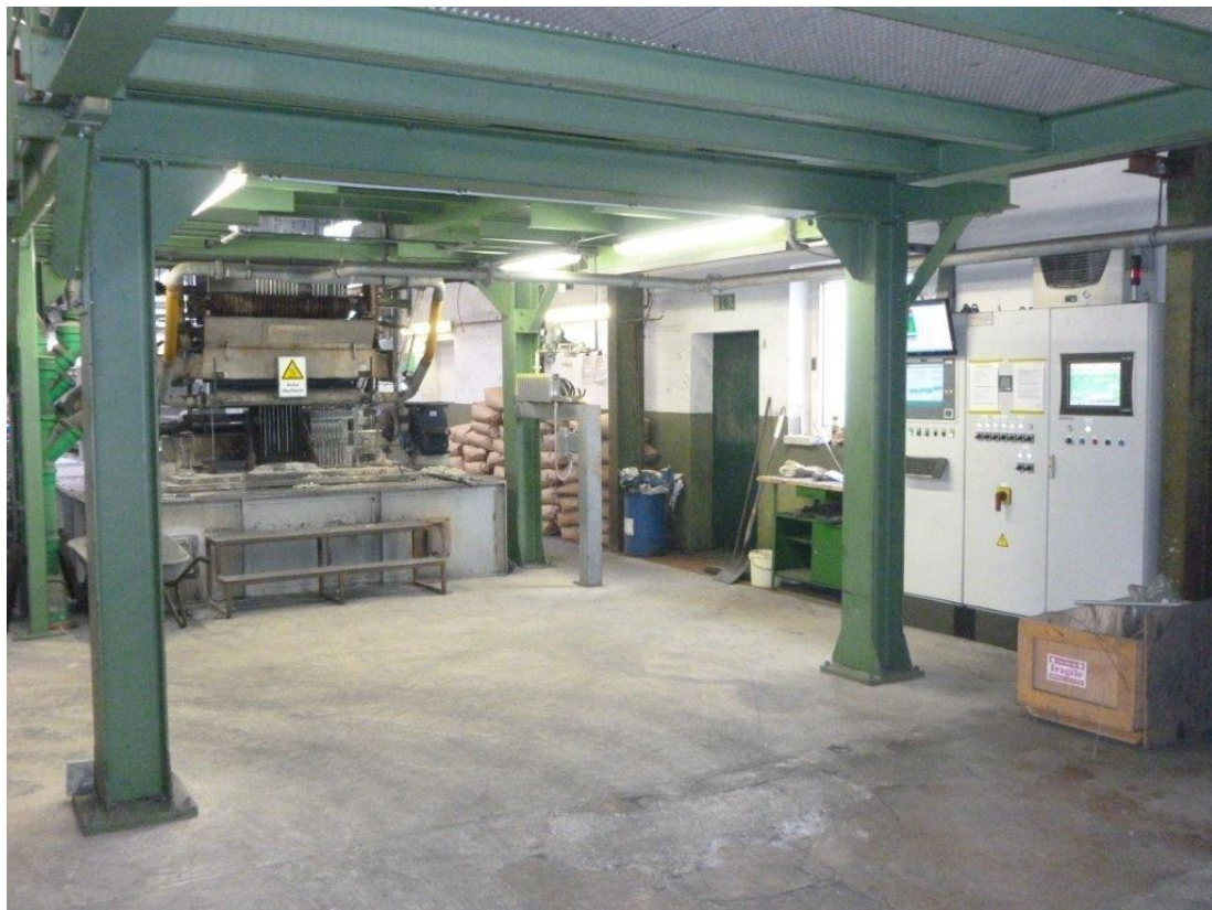
Abbildung 17: Stickstoffabstreifung und Schaltschrank Verzinkung
