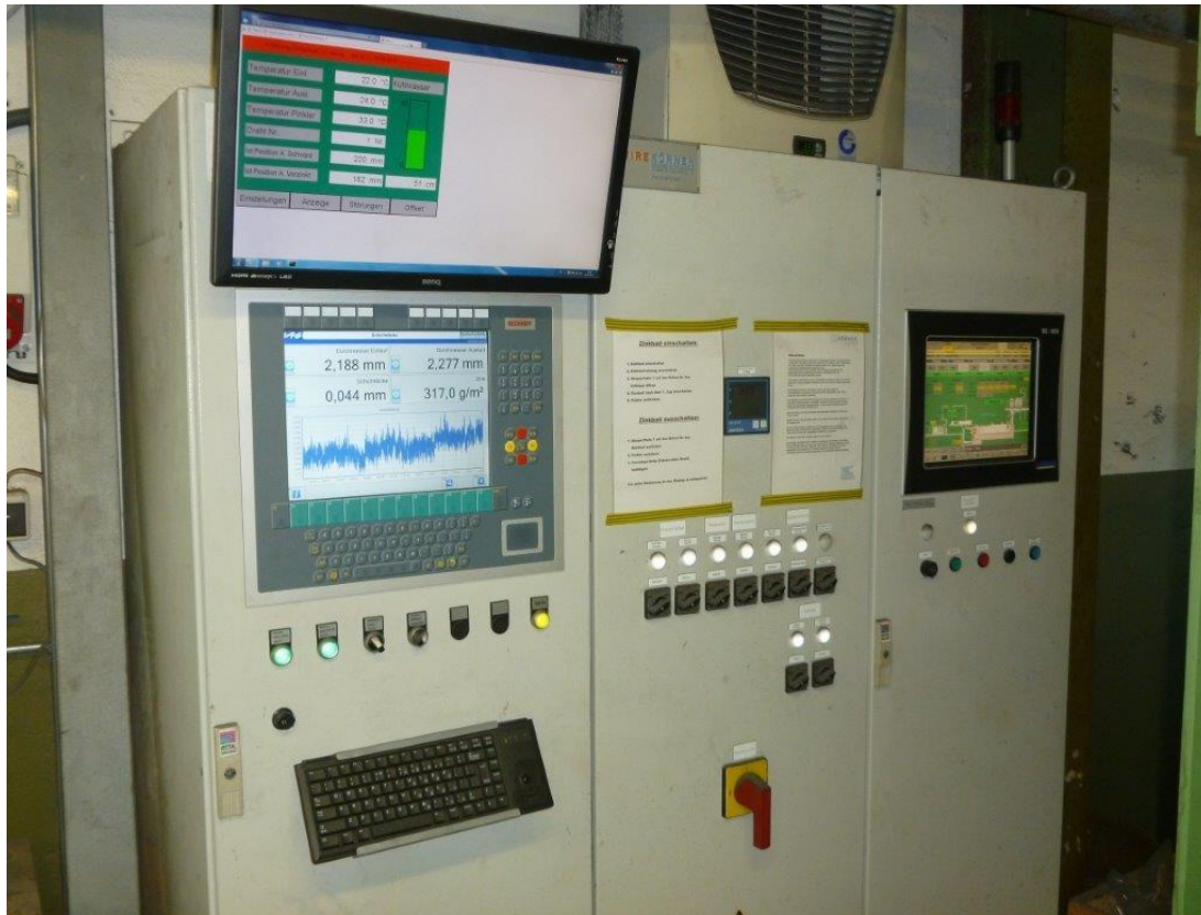
Abbildung 18: Bedienpult Verzinkung mit Durchmesser- und Temperaturanzeige
