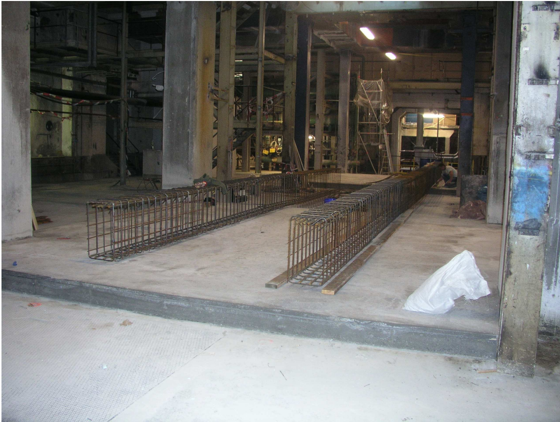
Abbildung 9: Blick in den Maschinenhauskeller mit Armierung für die Fundamentbrücken
