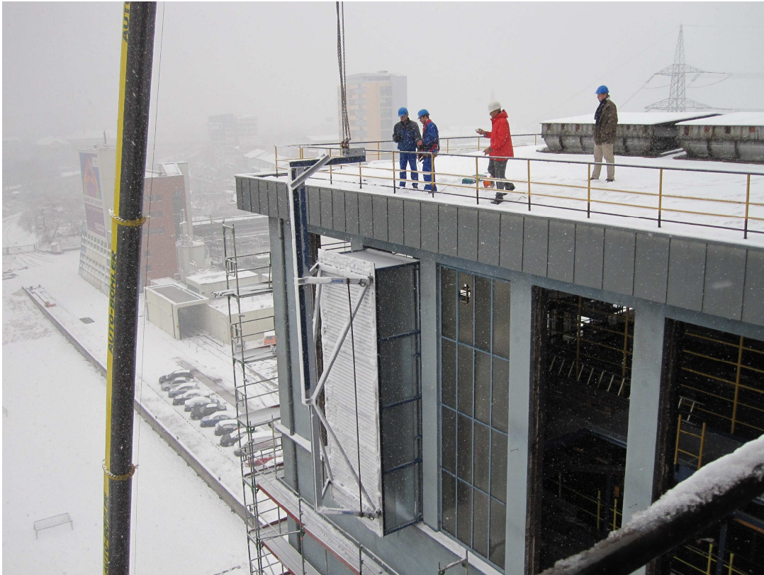
Abbildung 16: Montage der stehenden Wärmetauscher für die Regelkühlanlage
