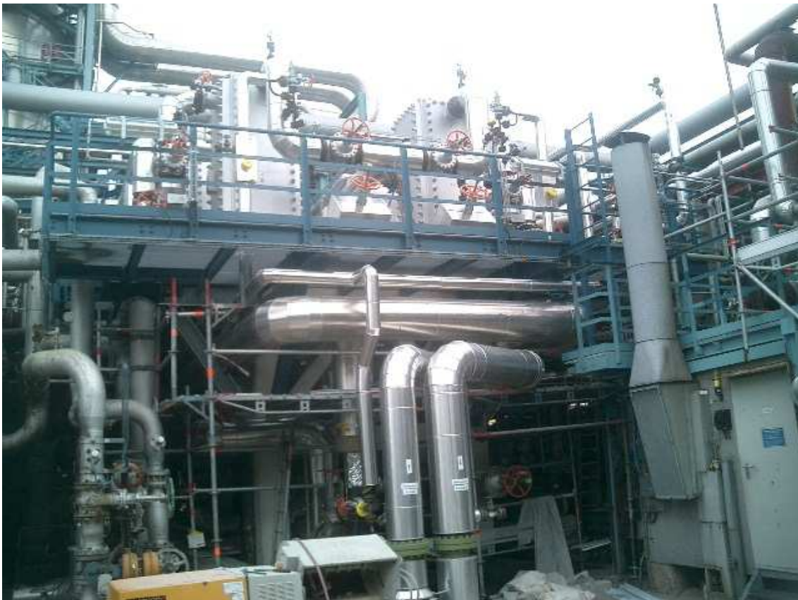
Abbildung 15: Mit ca. 20 MW größter Wärmetauscher bei MiRO
