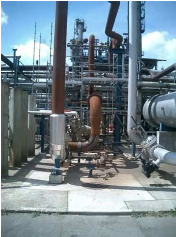
Abbildung 8: Verrohrungsarbeiten innerhalb der Raffinerie
