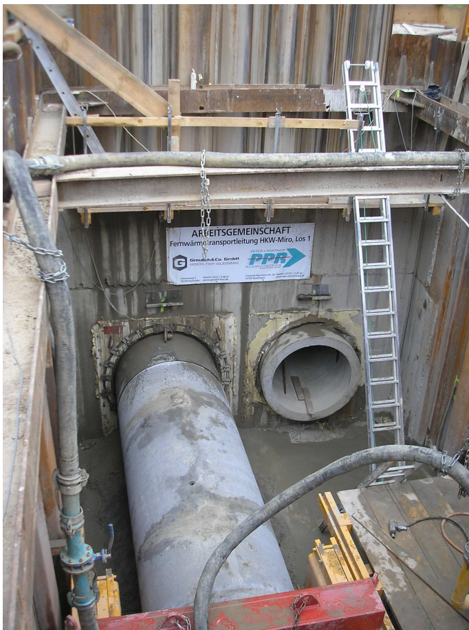
Abbildung 14: Blick in die Pressgrube
