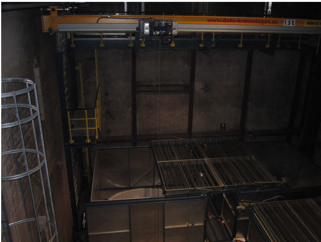
Abbildung 17: Blick ins Rückkühlgebäude auf die Lüftergehäuse mit Jalousien
