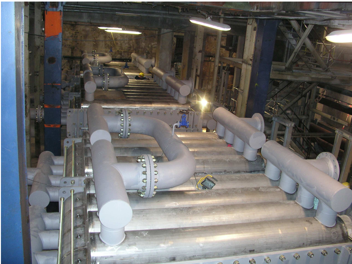
Abbildung 11: Blick auf die drei Wärmetauscherpakete im Maschinenhauskeller
