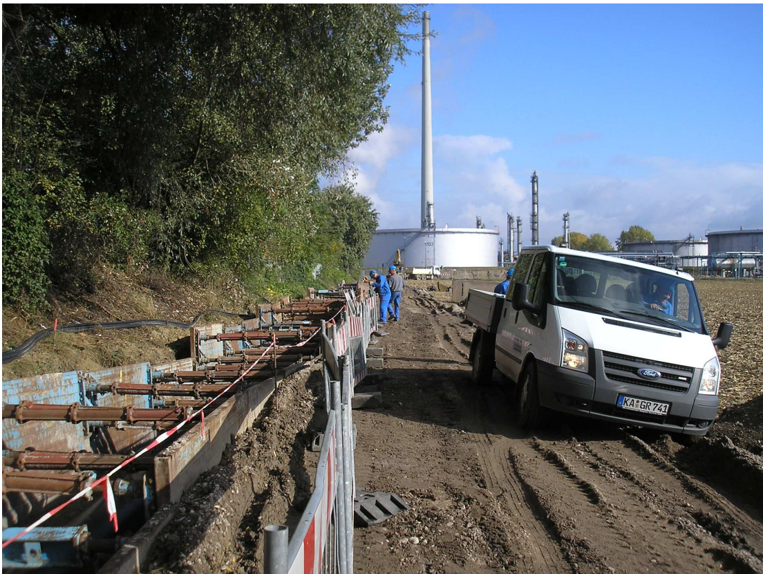
Abbildung 12: Baustelle im Frauenhäusleweg
