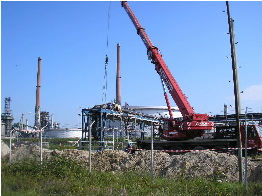
Abbildung 7: Installation der Rohrbrücke bei MiRO
