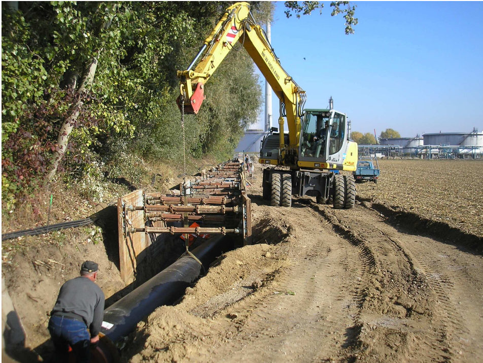
Abb. 2: Wärmetransportleitung kurz vor der Raffinerie
