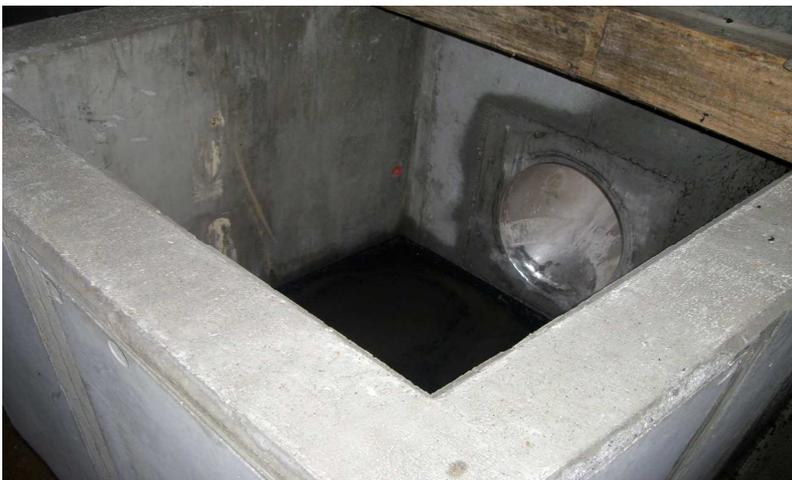
Abb.: Bodentrichter zum Abtransport der Sedimente
