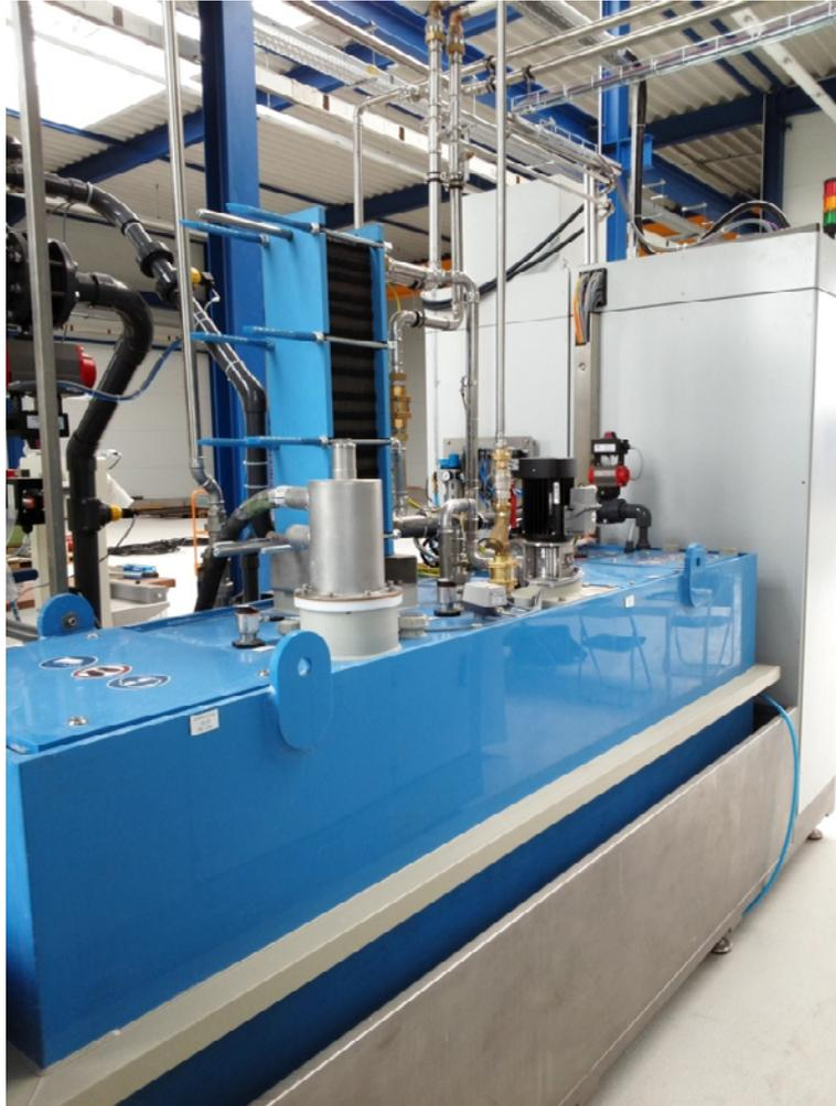
**Abbildung 8: Elektrolytaufbereitung**
