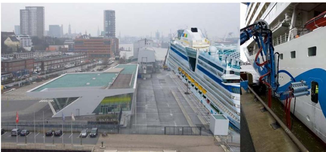
Abbildung 5 Links: Darstellung des Kreuzfahrtterminals Altona und der Landstromanlage mit der AIDASol am Kai. Rechts: Übergabeeinrichtung zum Schiff (Quelle: HPA).
