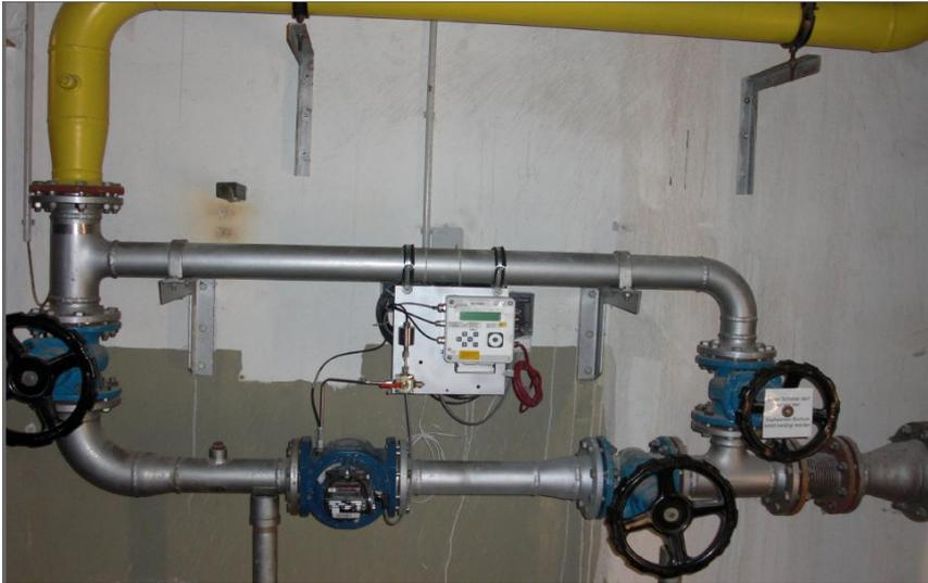
Abb. 2-12: Gaszähler der Kessel
