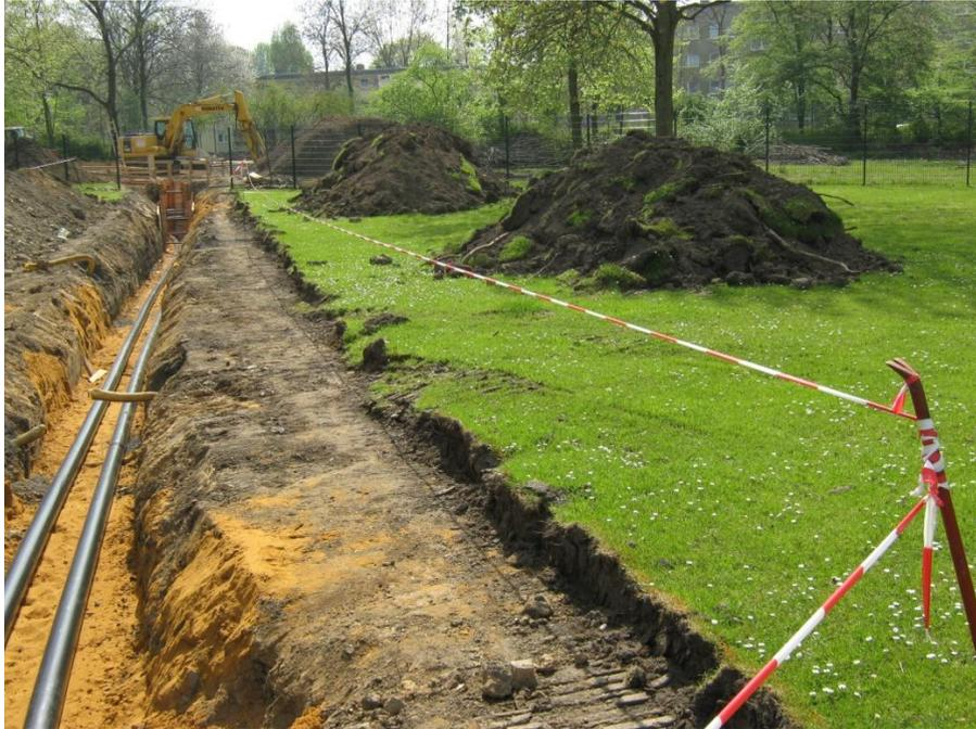
**Abb. 2-8: Foto: Verlegung der Leitungen der Verbindungsleitungen vom Abwasserwärmetauscher zu Wärmepumpe**
