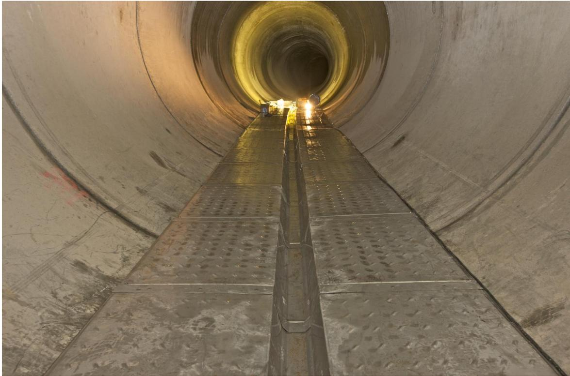
**Abb. 2-4: Wärmetauscher-elemente nach Fertigstellung**
