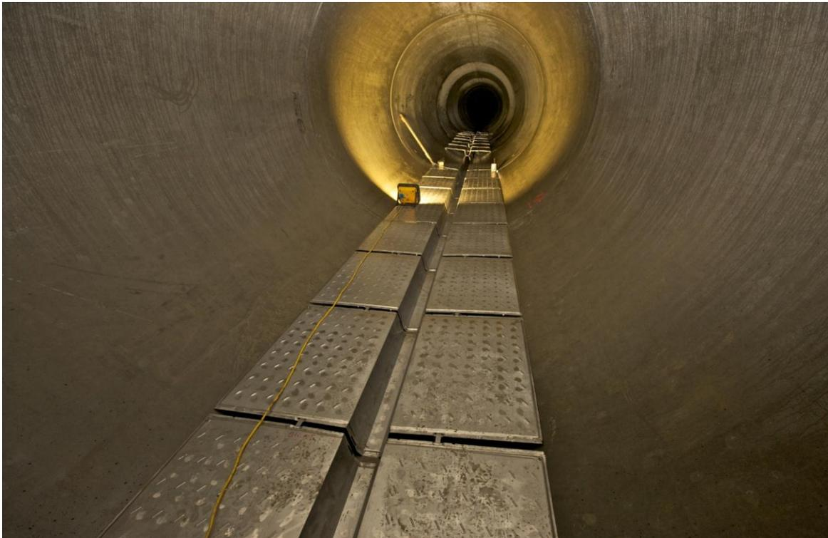
**Abb. 2-3: Foto: Montage der Wärmetauscherelemente**
