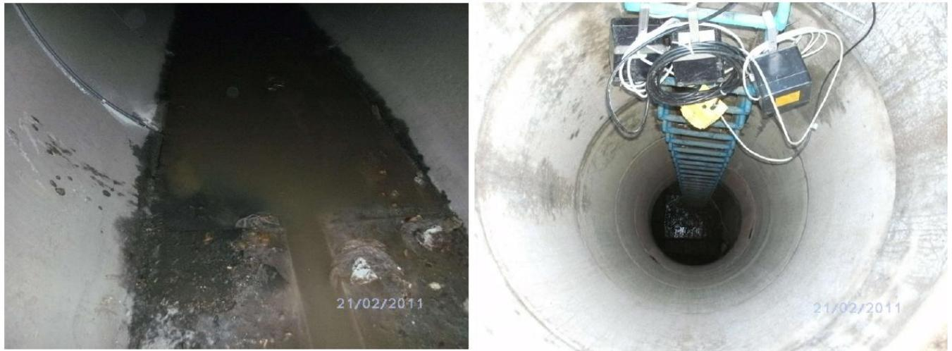
**Abb. 2-14: Referenzmessung der Abwassertemperatur und Datensammler im Schacht**
