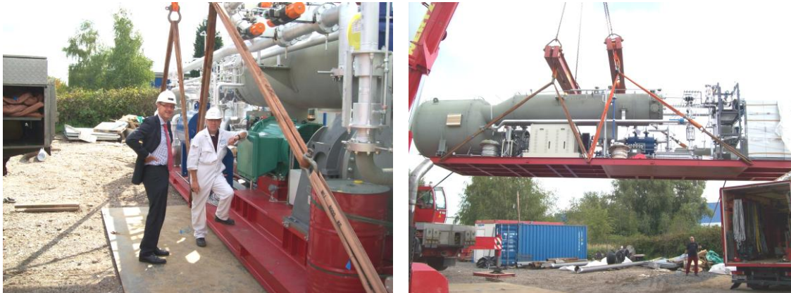
Abbildung 8: Anlieferung der ORC-Turbine [1]
