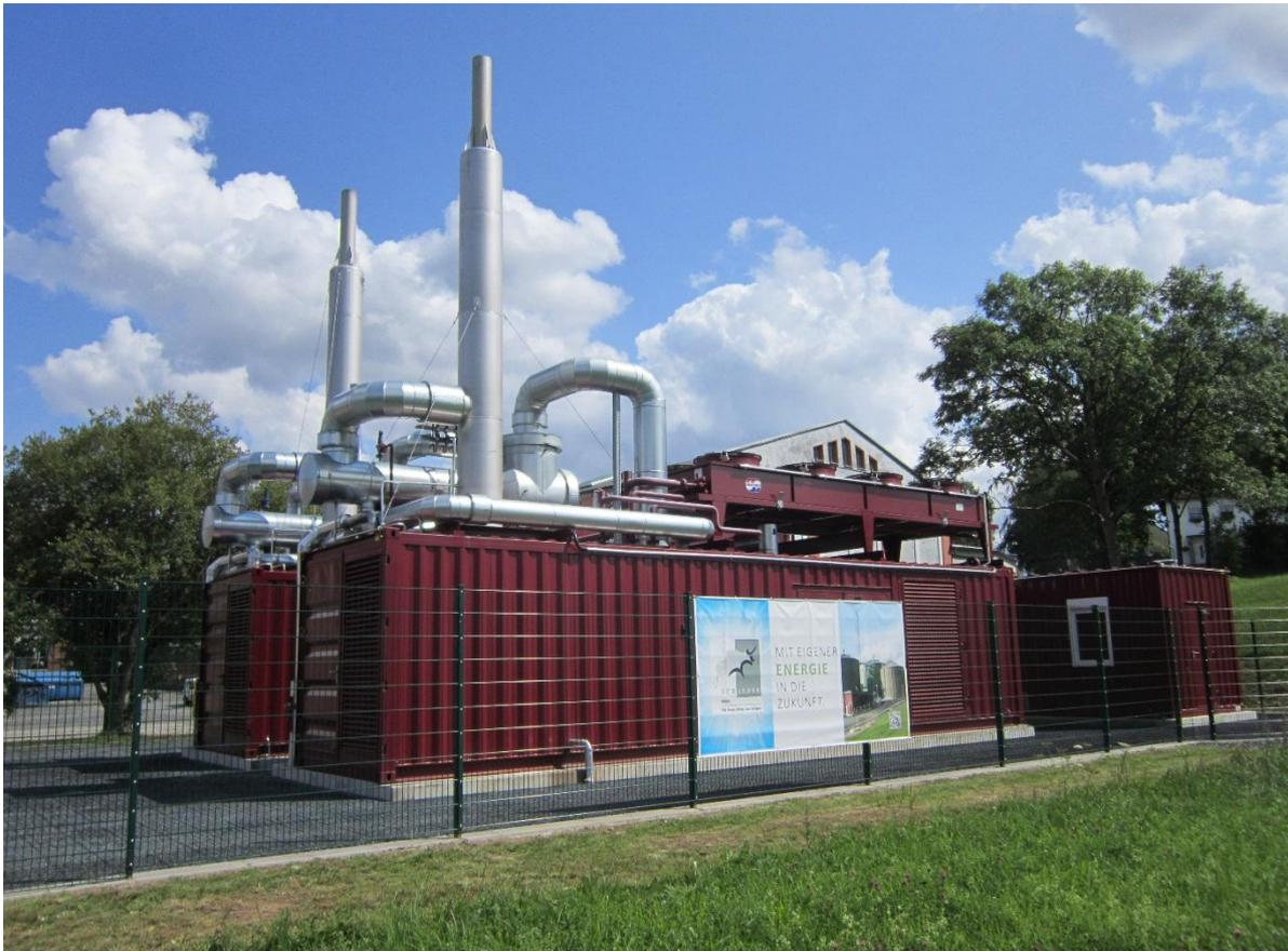
Abbildung 4: Die beiden BHKW-Container am Produktionsstandort Gerberstraße
