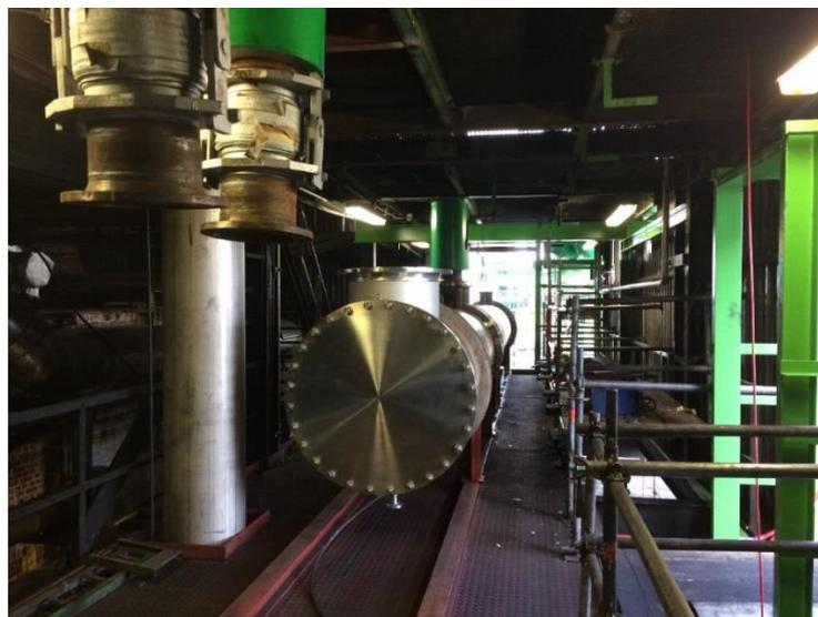
Abbildung 10: Hereinziehen des Wrasenkondensators, (November 2014)
