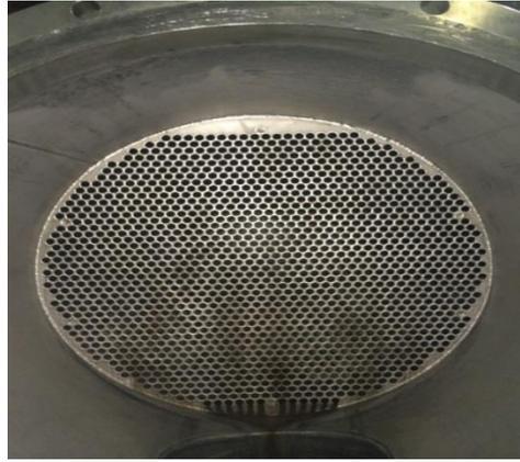
Abbildung 27: Austrittsseite des Kondensators, Foto vom 28.05.2015
