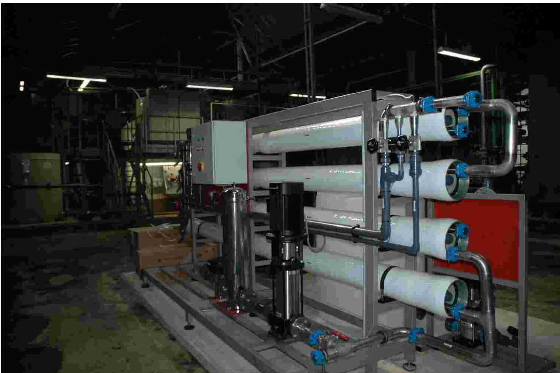
Abb. 7: Ansicht der Umkehrosmoseanlage
