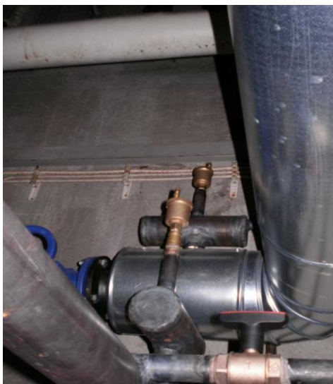
Abb. 23 - Lufttöpfe mit Automatikentlüfter
