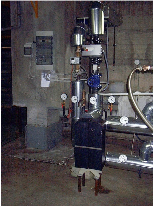
Abb 13 - Übergabestation im Technikgeschoß Hallenbad mit Plattenwärmetauscher (schwarz) und der Datenübertragung im kleinen Schaltkasten an der Säule links.
