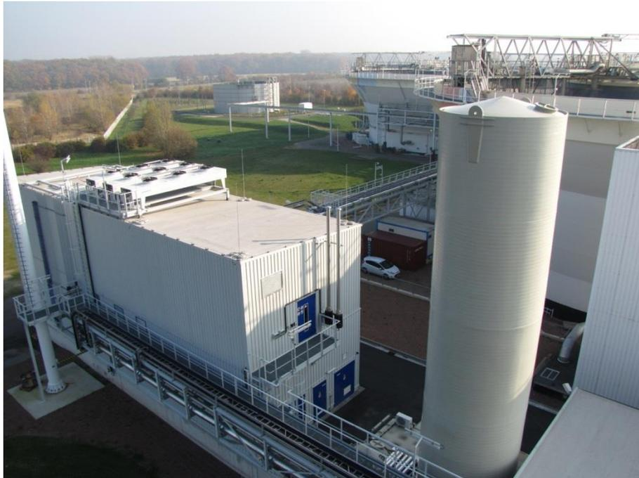
Abb. 14: Turmkolonne für die Biogasentschwefelung (rechts) und Gebäude für BHKW (Erdgeschoß) und Gasspeicher (Obergeschoß)
