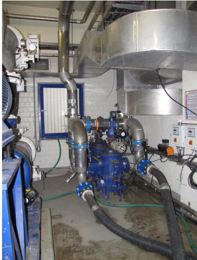
Abb. 6: BOLL-Filter zur Feststoffabtrennung aus dem Kommunalabwasser, Spaltweite 500  $\mu\text{m}$ .
