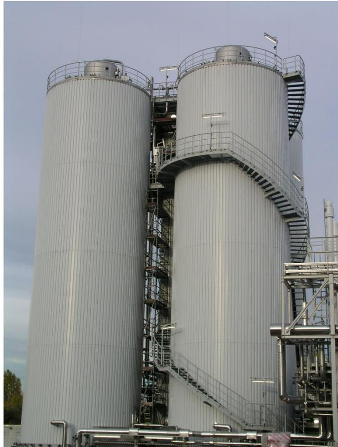
Abb. 8: Wahrzeichen der neuen Vorbehandlungsanlage im GWK Bitterfeld-Wolfen: Anaerobreaktoren Aquatyx, Typ R2S
