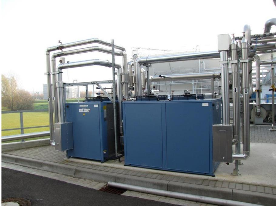
Abb. 16: Biogastrocknung und -druckerhöhung
