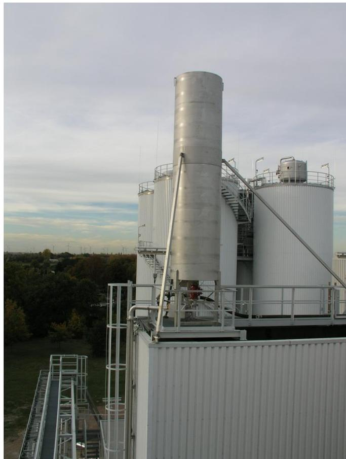
Abb. 17: Fackel und Kontrollstation (im Hintergrund Anaerob-Reaktoren)
