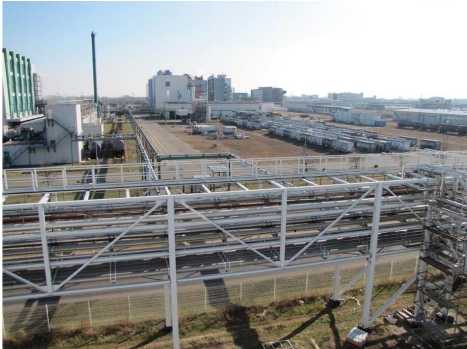
Abb. 1: Rohrbrücken auf dem Gelände des GWK und des Industrieparks Bayer Bitterfeld mit Druckleitungen für Methylcelluloseabwasser, Hintergrund Bildmitte: Dow Wolff Cellulosics (Foto Sterger am 28.02.2011)
