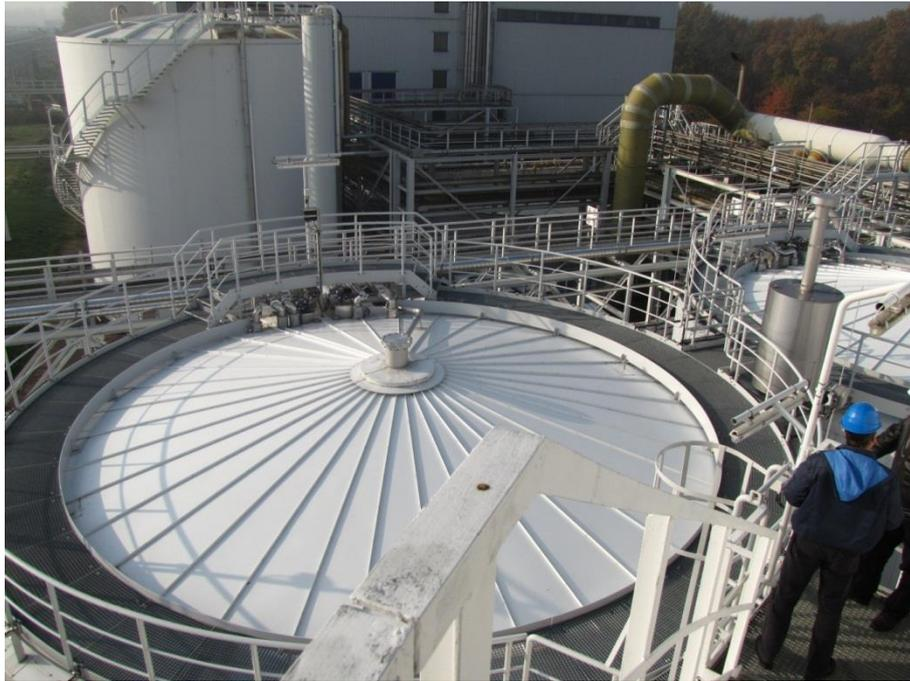
Abb. 3: Ausgleichsbehälter für Methylcelluloseabwasser (im Vordergrund)
