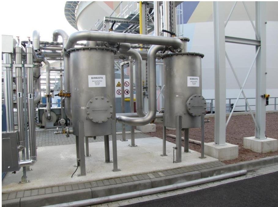
Abb. 15: Aktivkohlefilter zur Biogasreinigung (Hintergrund: BIOHOCH<sup>®</sup>-Reaktor 1)
