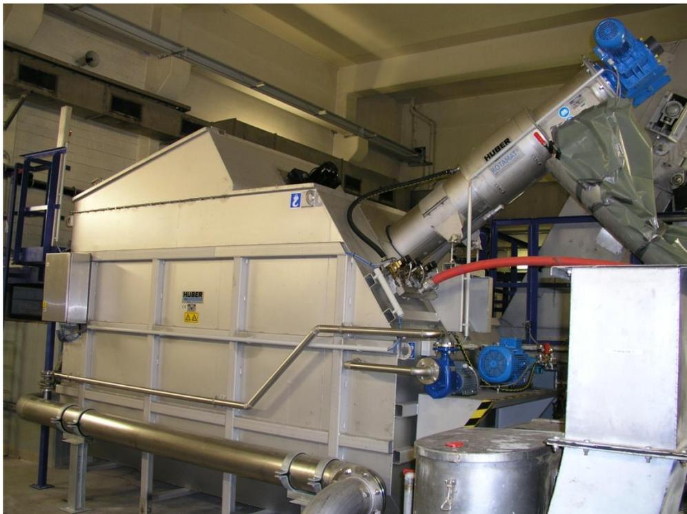
Abb. 5: HUBER-Feinsiebanlage zur weitergehenden Feststoffabtrennung aus Kommunalabwasser, Maschenweite 1 mm.
