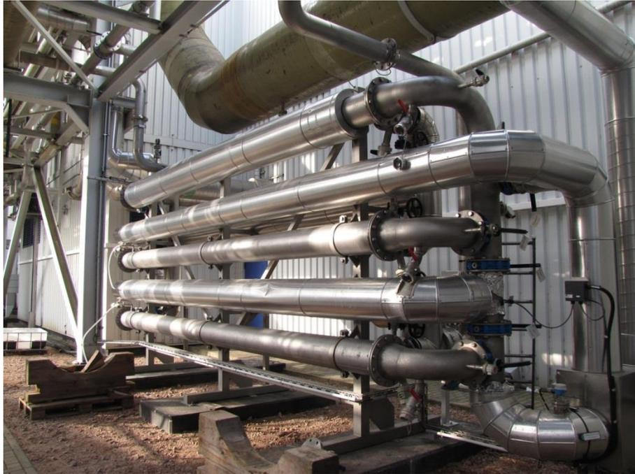
Abb. 7: Wärmetauscher 4 zur Vorwärmung des Kommunalabwassers
