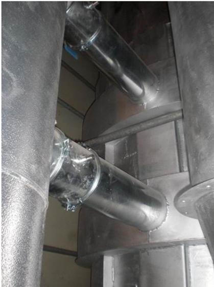
Bild 12: Zustrom der heißen Luft ins Scherbensilo im Gemengehaus über isolierte Leitung
