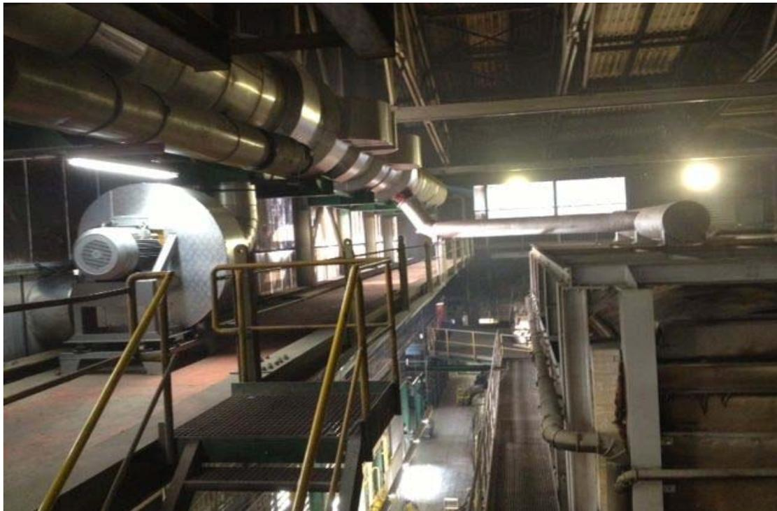
Bild 10: Installation des Warmluftsammlers (rechts im Bild), des 1. Wärmetauschers und des Gebläses für den Wärmetransport beendet
