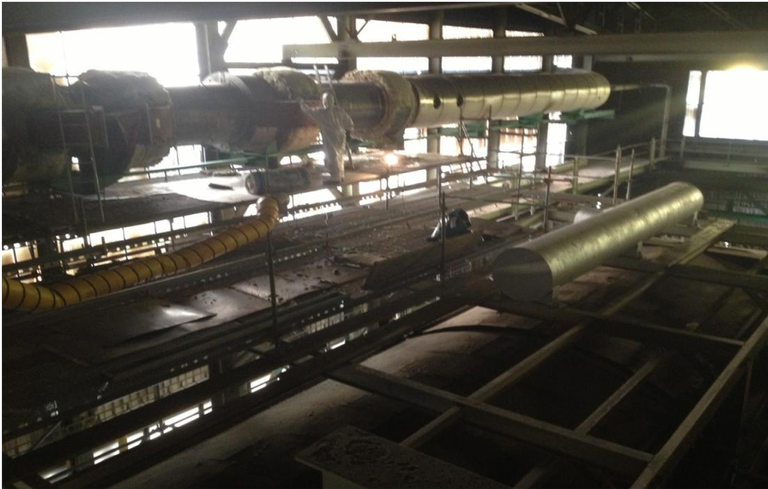
Bild 9: Startphase – Beginn der Arbeiten: Montage des Warmluftsammlers über dem Regenerator bereits erfolgt, Entfernen der Isolierung am Abgaskanal zur Montage des 1. Wärmetauschers
