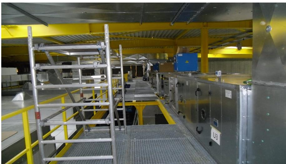
Abbildung 11: Einbau der Lüftungstechnik in die Lackieranlage (Foto vom 16.10.2014)
