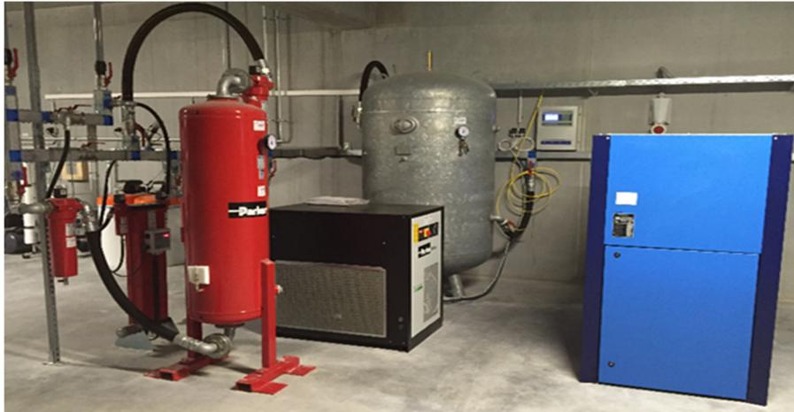
Abbildung 23: Abbildung der Druckluftversorgungsstation (Foto vom 07.09.2015)
