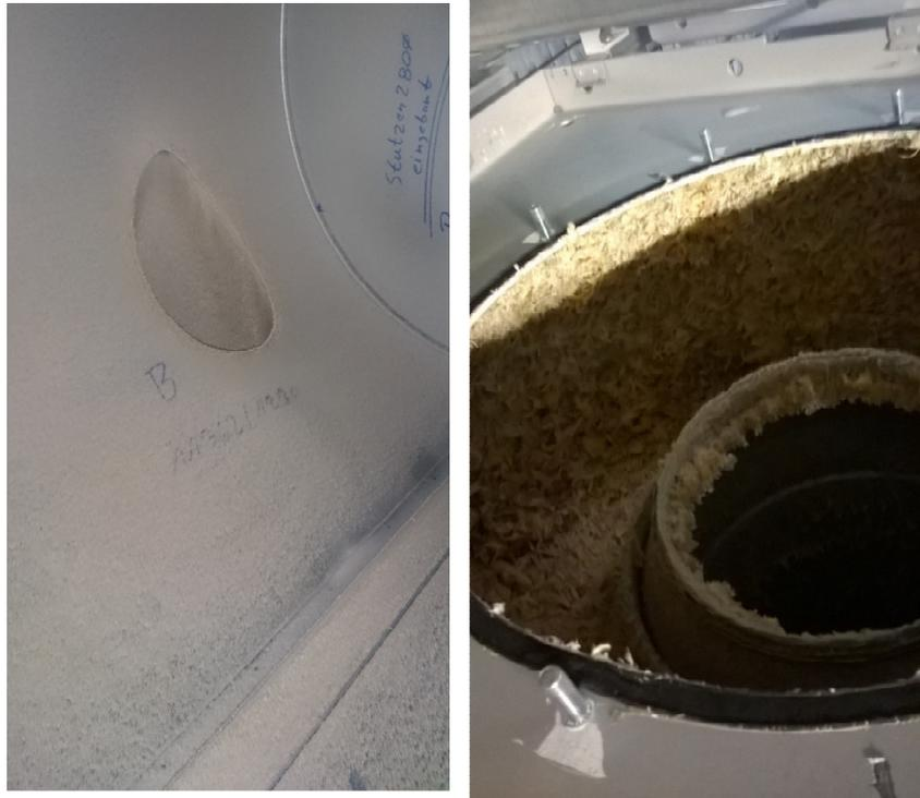
Abbildung 25: Lackablagerung im Abluftkanal (links) und Abluftventilator (rechts)
