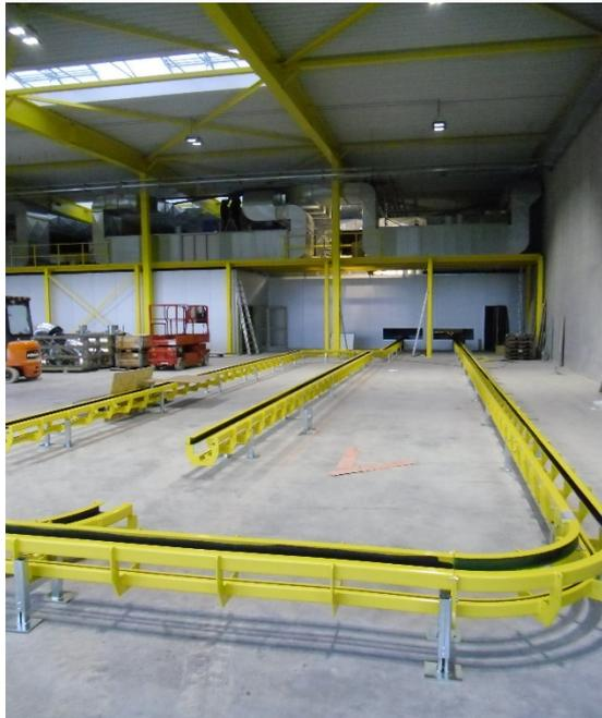
Abbildung 12: Einbauarbeiten zur Fördertechnik der Lackieranlage (Foto vom 23.10.2014)
