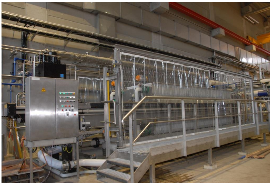
Abb. : Beheizbare Membranfilterpresse bei der Aurubis AG in Hamburg
