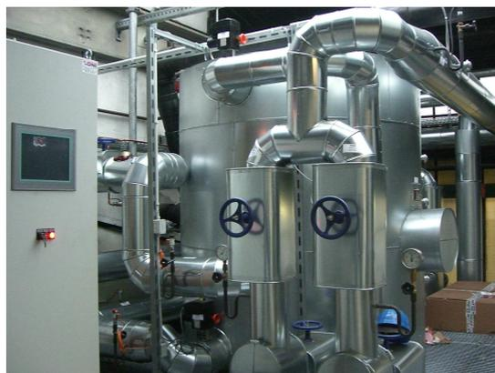
Abbildung 11: Hydraulische Weiche auf der Technikzentrale
