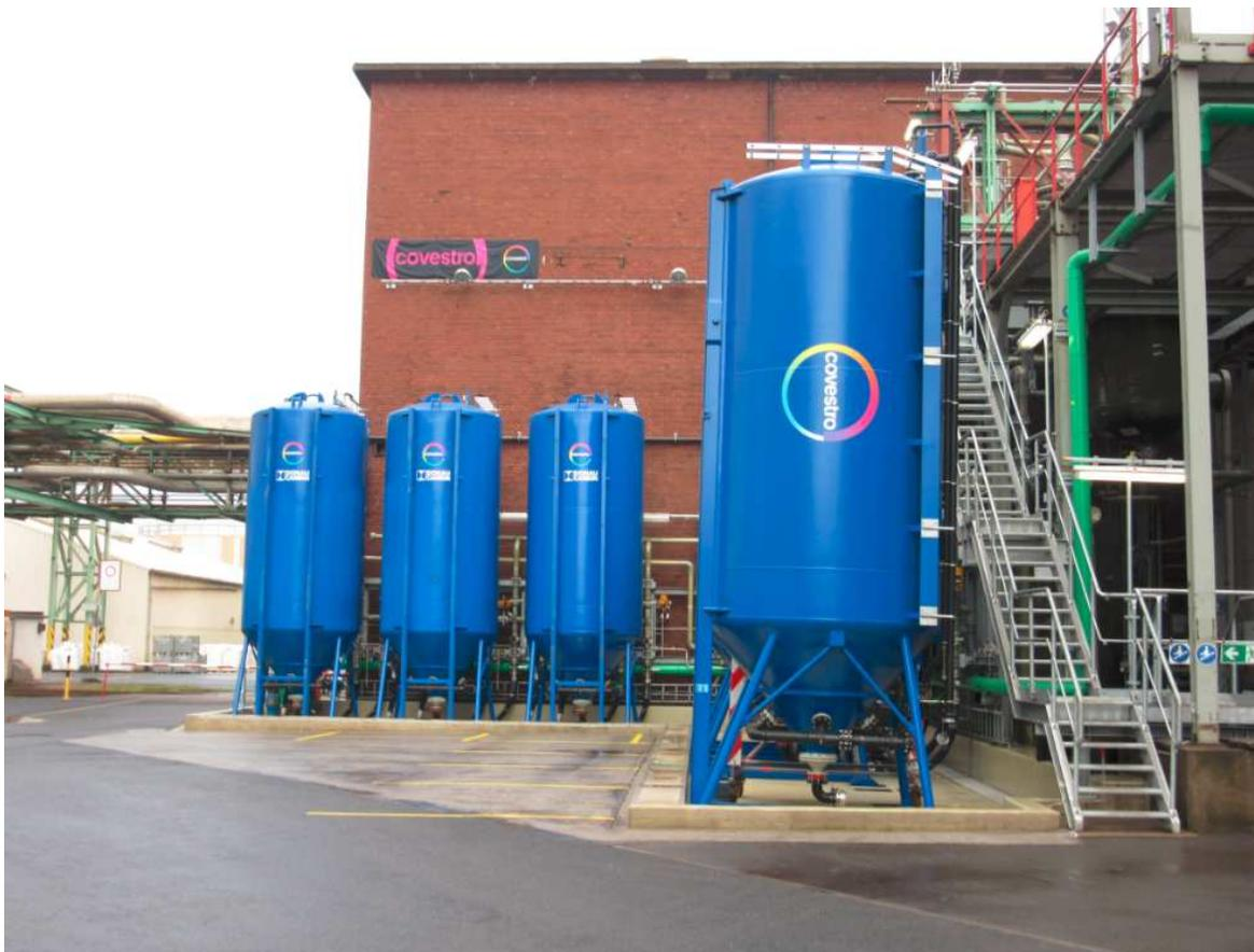
Abbildung 4: Mobile Adsorber der Adsorptionsstufe
