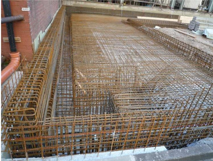
Abbildung 9: Tanktasse vor dem Betonieren
