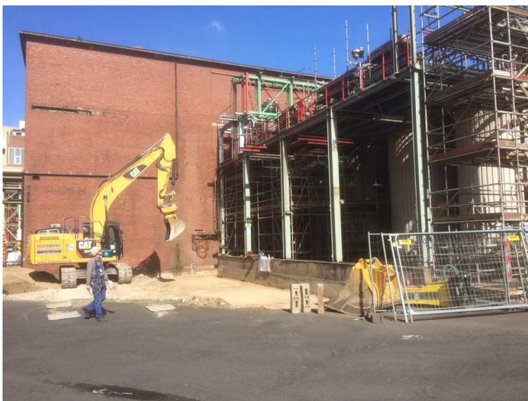
Abbildung 8: Vorbereitende Tätigkeiten für die Gründung der Tanktasse
