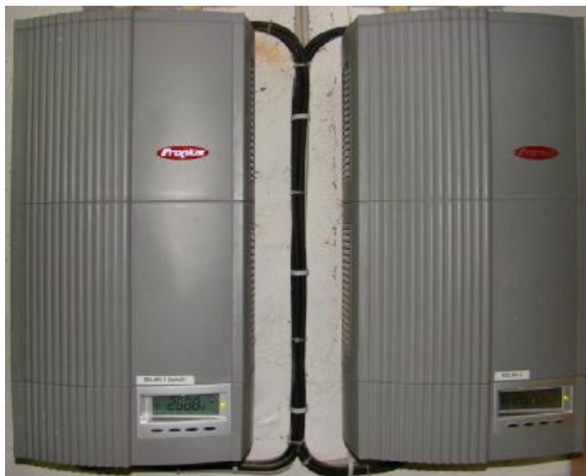
Wechselrichter von Fronius
