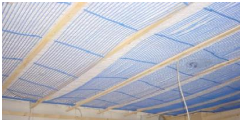
Kapillarrohrmatten und eine neue Innenwand
