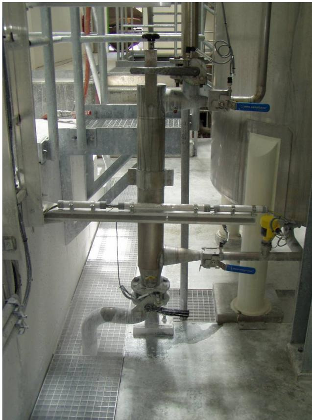
**Abb. 27: Nachsiegung (150µm Filter)**
