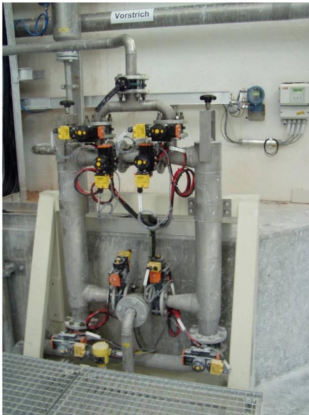
**Abb. 17: Redundanter 300µm Druckfilter mit Rückspülfunktion**
