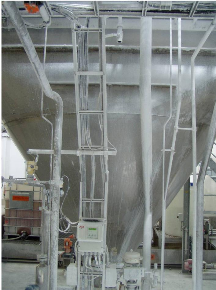
**Abb. 22: Abzugskonus am Sediflott mit eingebautem Krähwerk**
