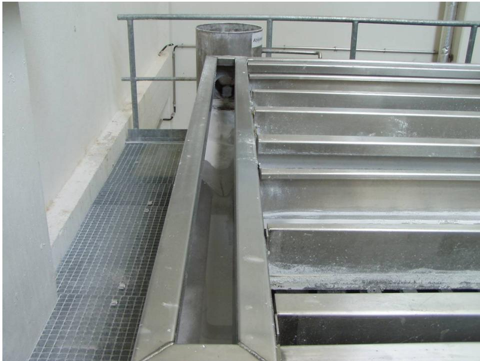
**Abb. 21: Klarwasserüberlauf am Sediflott**
