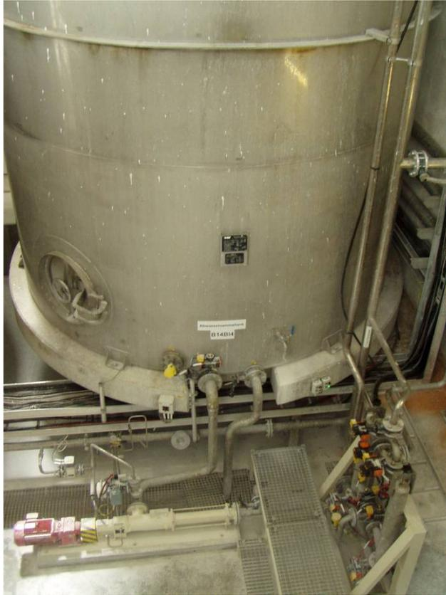
**Abb. 16: Pufferbehälter mit Abzugspumpe**
