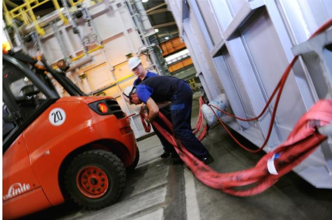
Abbildung 16: „Vorbereitung eines montierten Ofens zum Verschieben an den endgültigen Standort“
