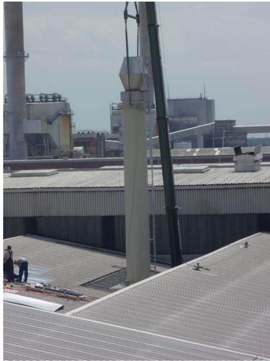
Abbildung 8: „Kamininstallation durch geöffnetes Hallendach“
