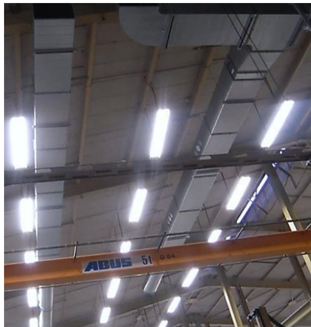
Abbildung 7 Montage des Abluftstrangs
