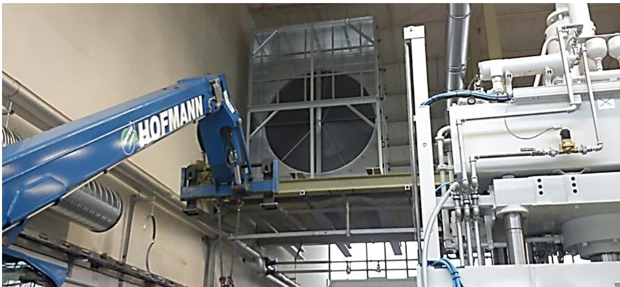
Abbildung 16 Montage des Wärmerads
