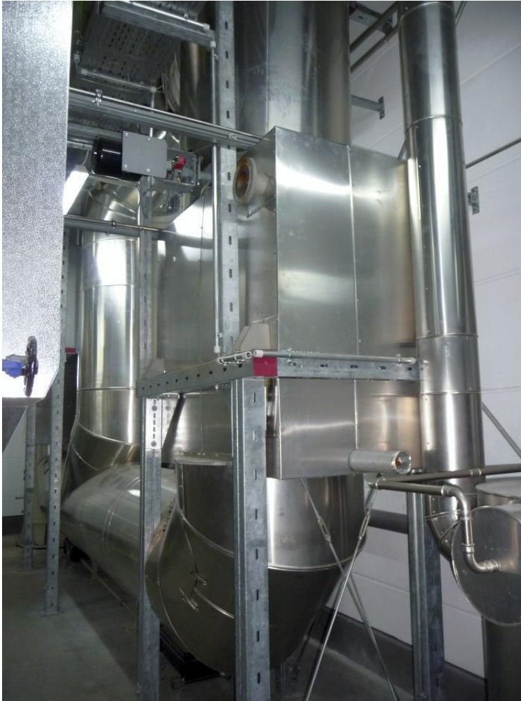
Abbildung 3-10 Abgas Brennwerttauscher
