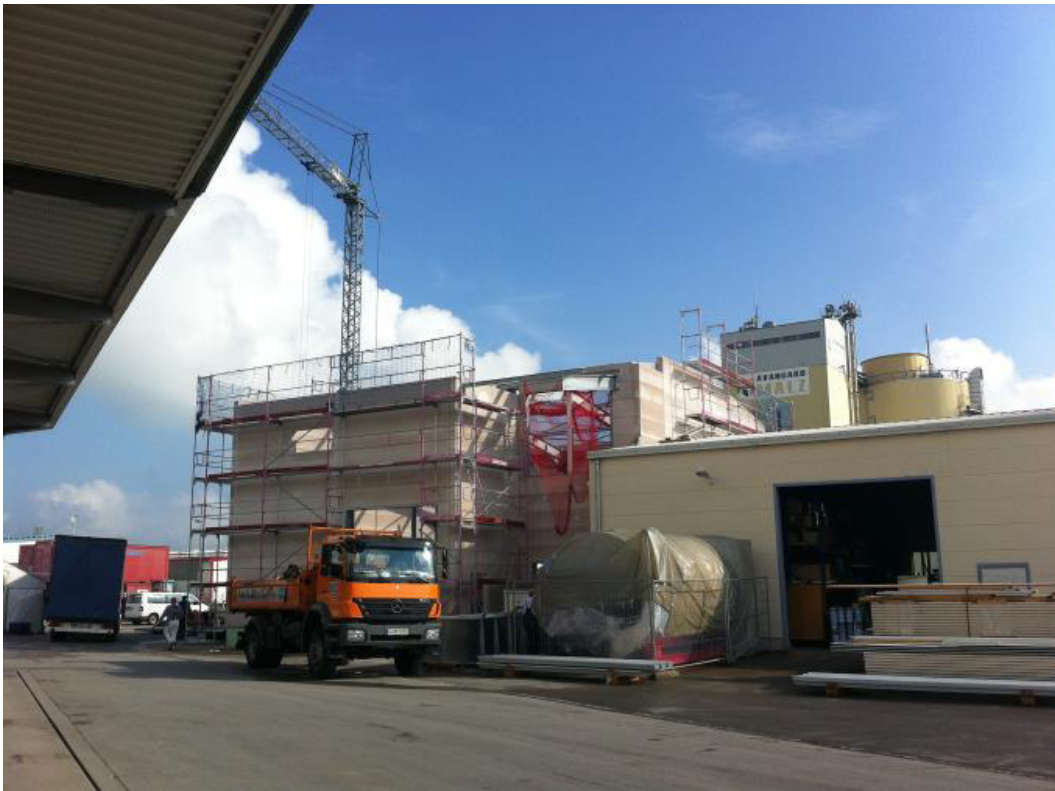
Abbildung 2-3 Neubau Kesselhaus (Aufnahme Juni 2013)
