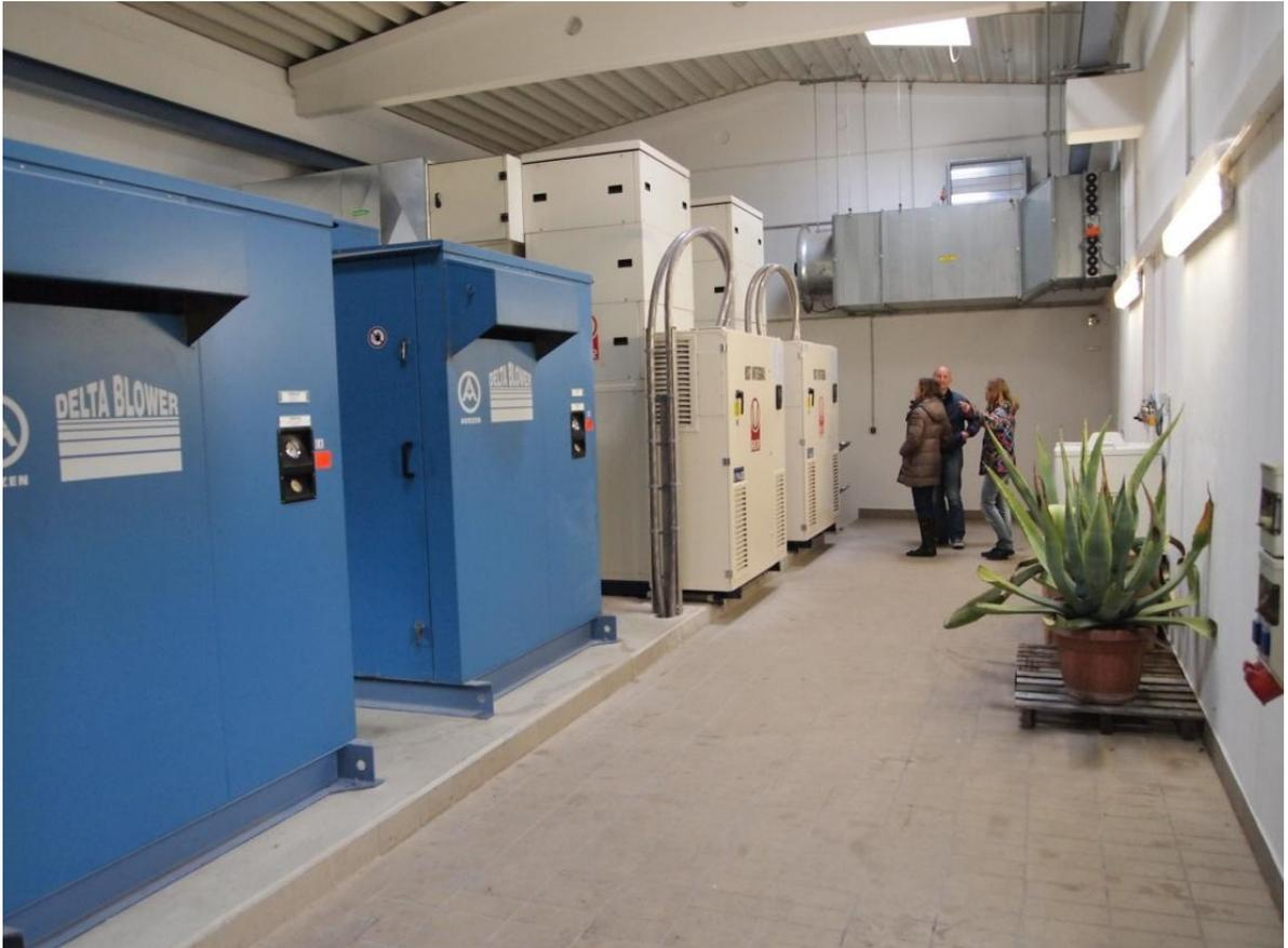
Abbildung 1.2 Gebläsestation mit Drehkolbengebläsen und Turboverdichtern (hinten)
