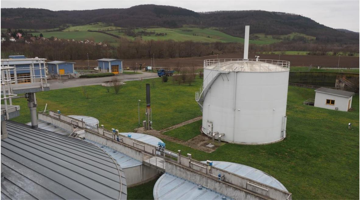
Abbildung 2.3 Gasspeicher mit Fackel und Gasvorschacht
