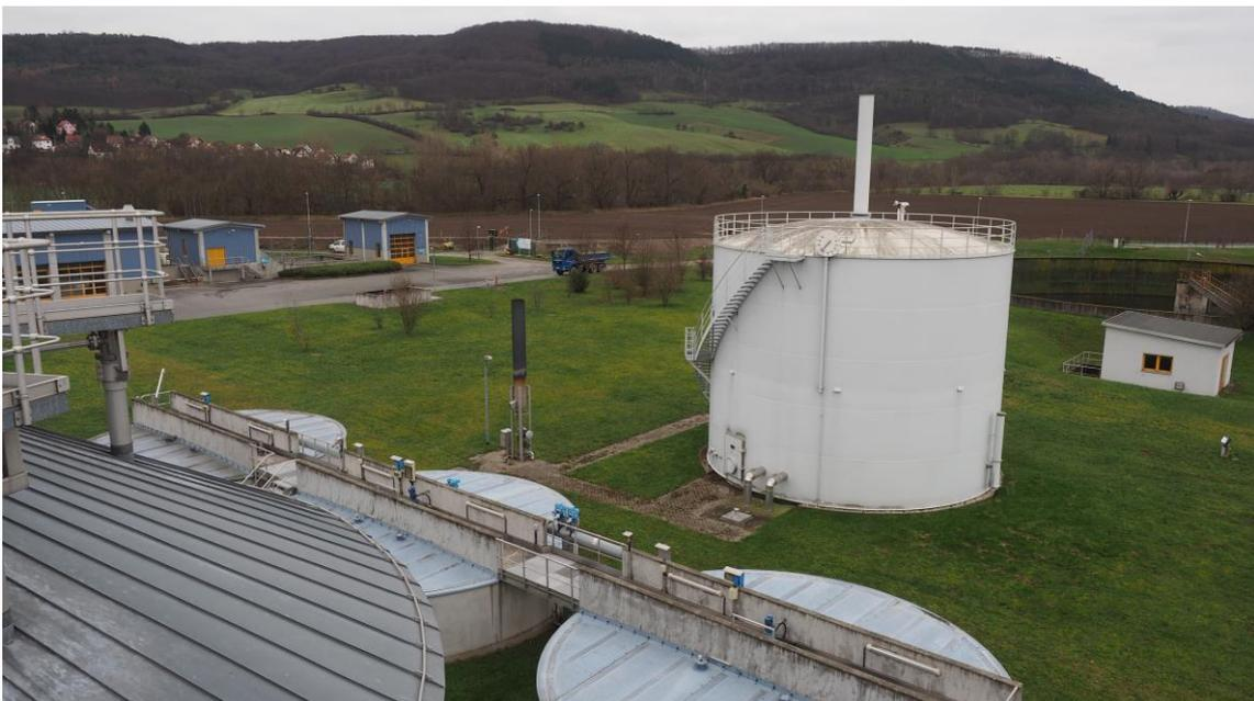
**Bild 3 : Gasspeicher mit Fackel und Gasvorschacht**
