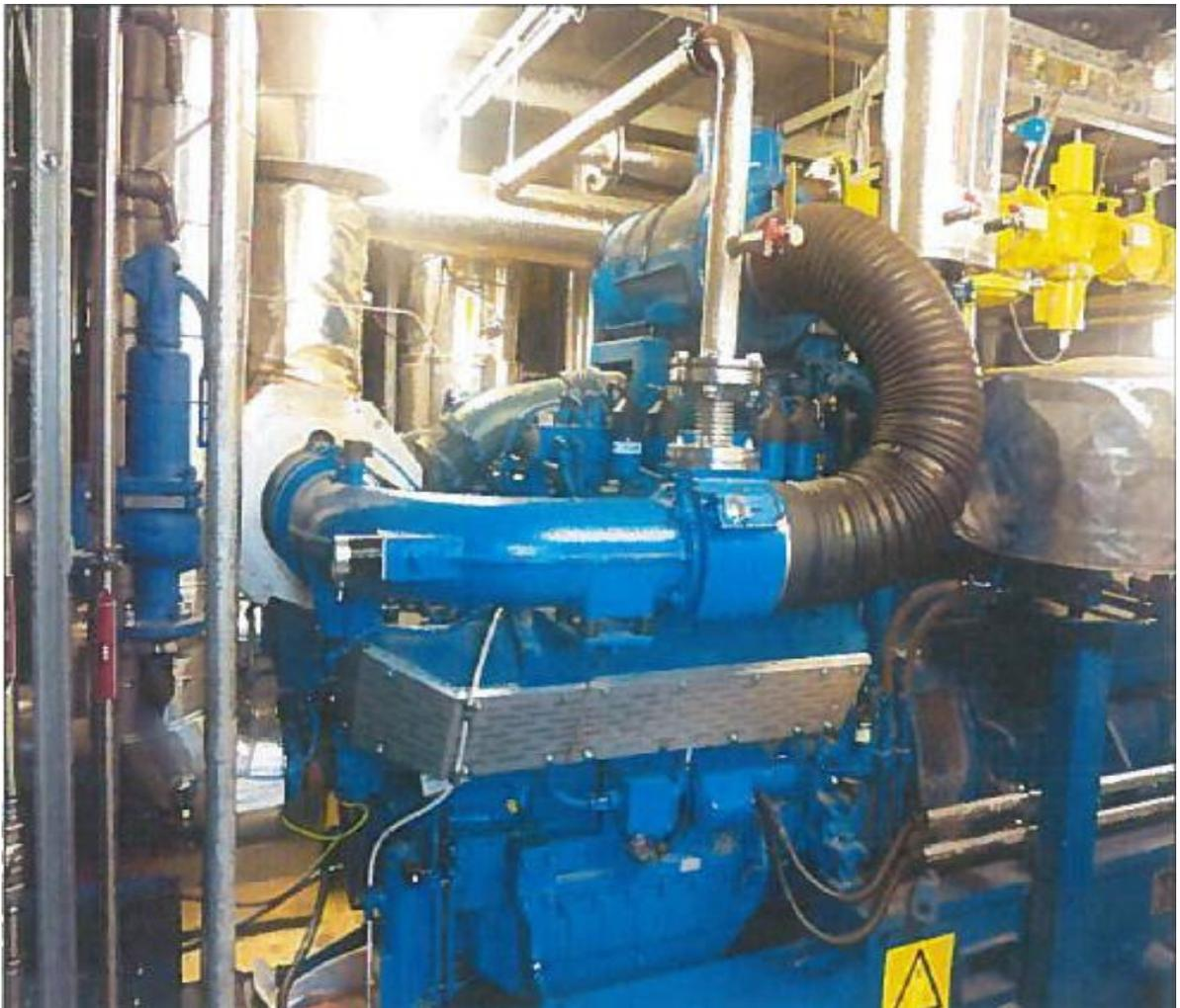
Abbildung 2.5 Grundlast BHKW, 400 KW
