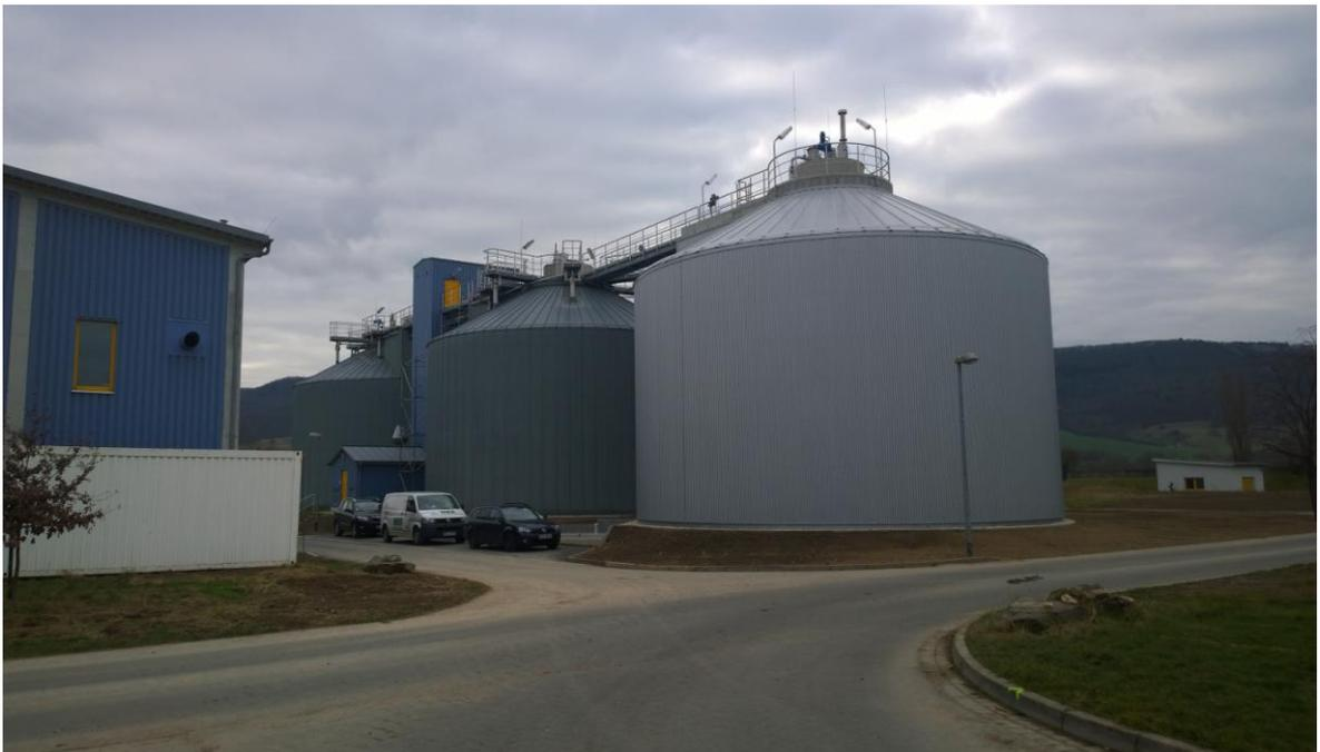
Abbildung 2.1 neuer Faulbehälter III, dahinter Faulbehälter I + II
