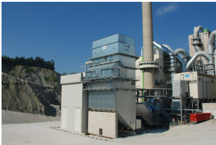
Bild 2-6 SCR-Anlage
