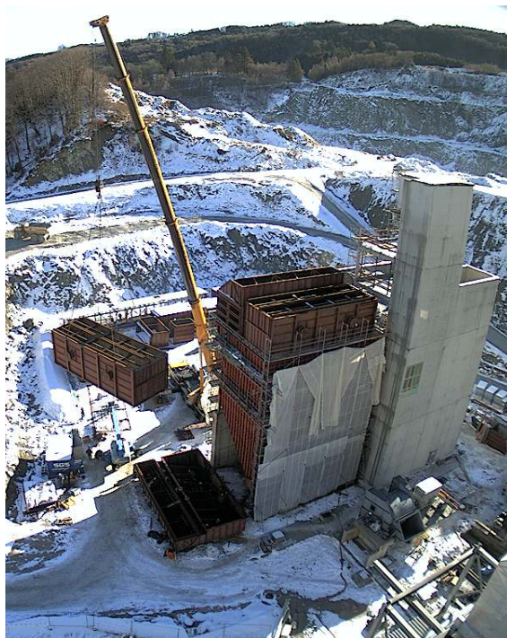
Bild 2-5 Montage des SCR-Reaktors
