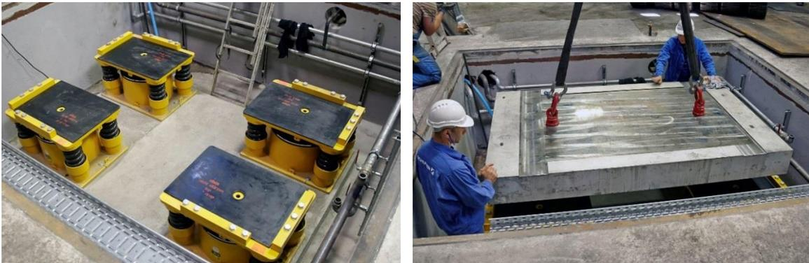
Bild 11/12: Fundament mit Dämpfungselemente und Grundplatte
