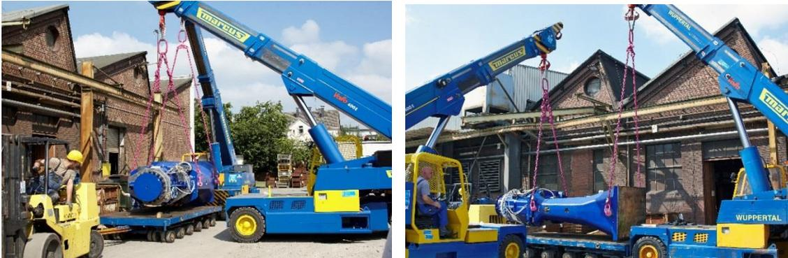
Bild 9/10: Entladen und Montage des Linearhammers
