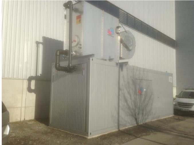
Abbildung 16: Rückkühlanlage vor der Halle nach Installation im November 2014
