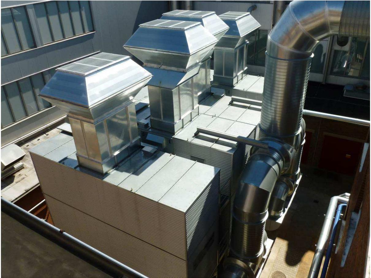
Abbildung 35 Filteranlage Dachansicht
