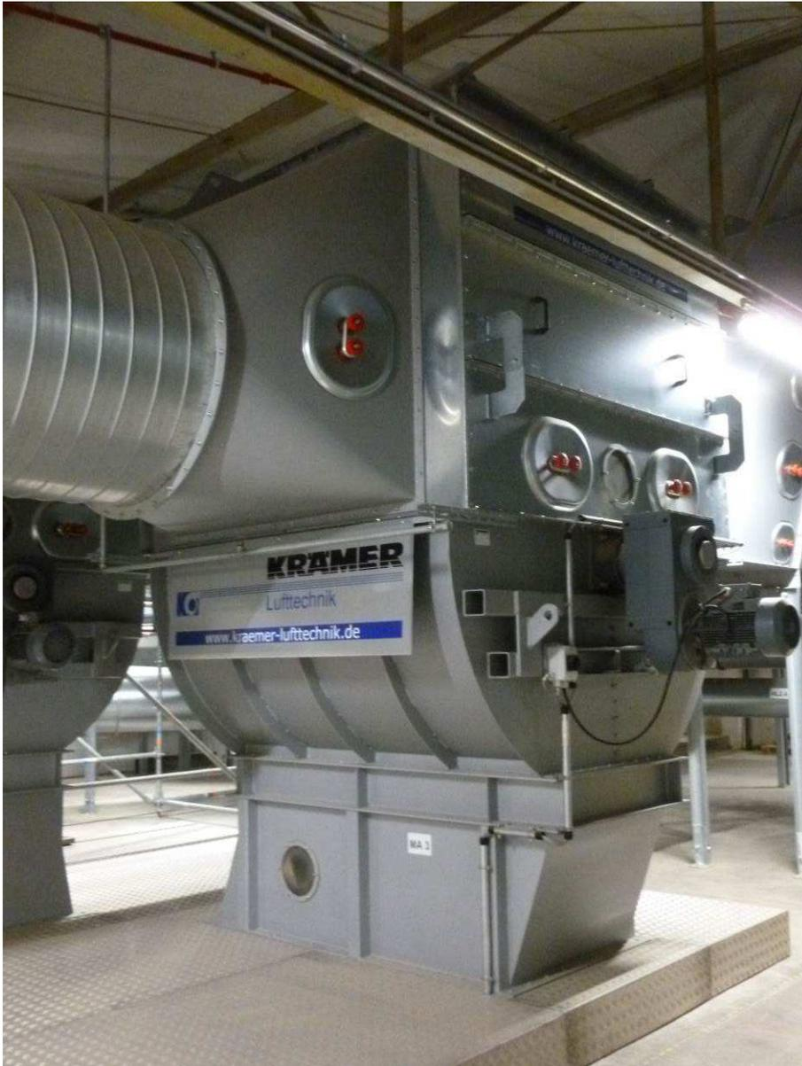
Abbildung 32 Materialabscheider für Presse 3 (insg. 5 vorhanden)
