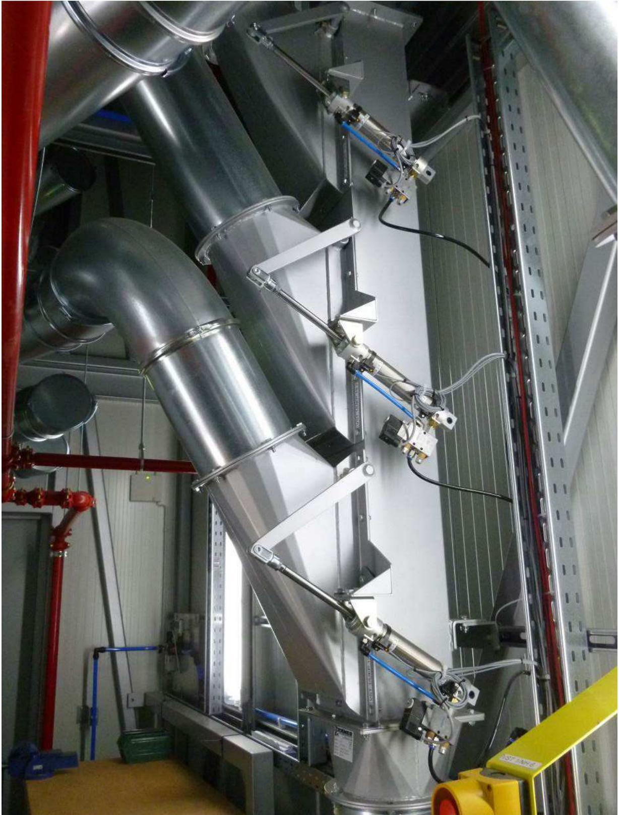
Abbildung 26 Weichenbaum über Stützventilator
