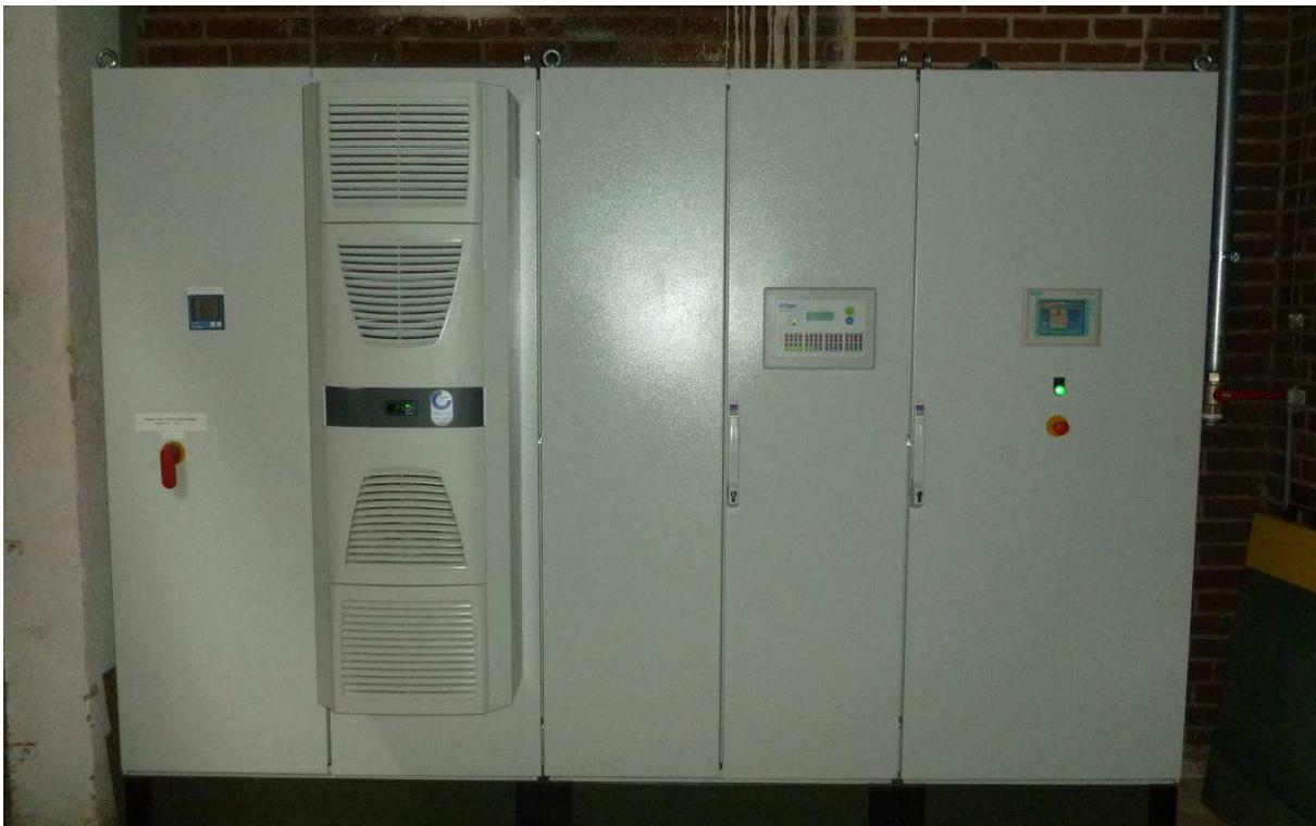
Abbildung 36 Schaltanlage der Filteranlage
