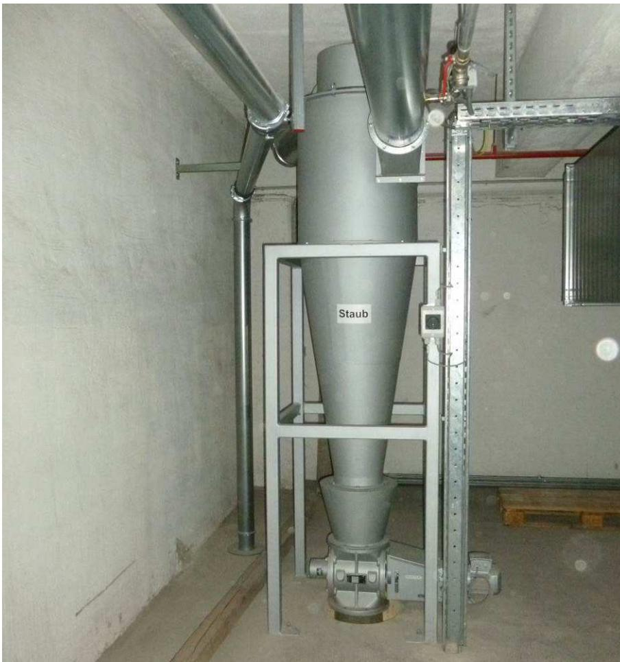
**Abbildung 38** Zyklon zur Staubabscheidung
