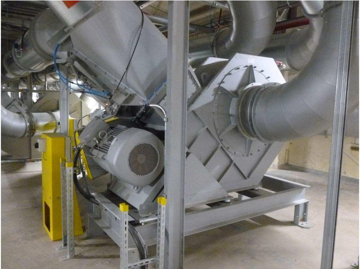
Abbildung 31 Hauptventilator HV 2.2 (hier nur einer von insg. 8 in vier Leistungen und unterschiedlichen Ausführungen)
