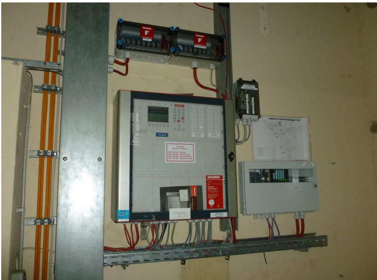
Abbildung 42 Funkenlöschanlage FLA 4 für den Bereich der Papierverarbeitung
