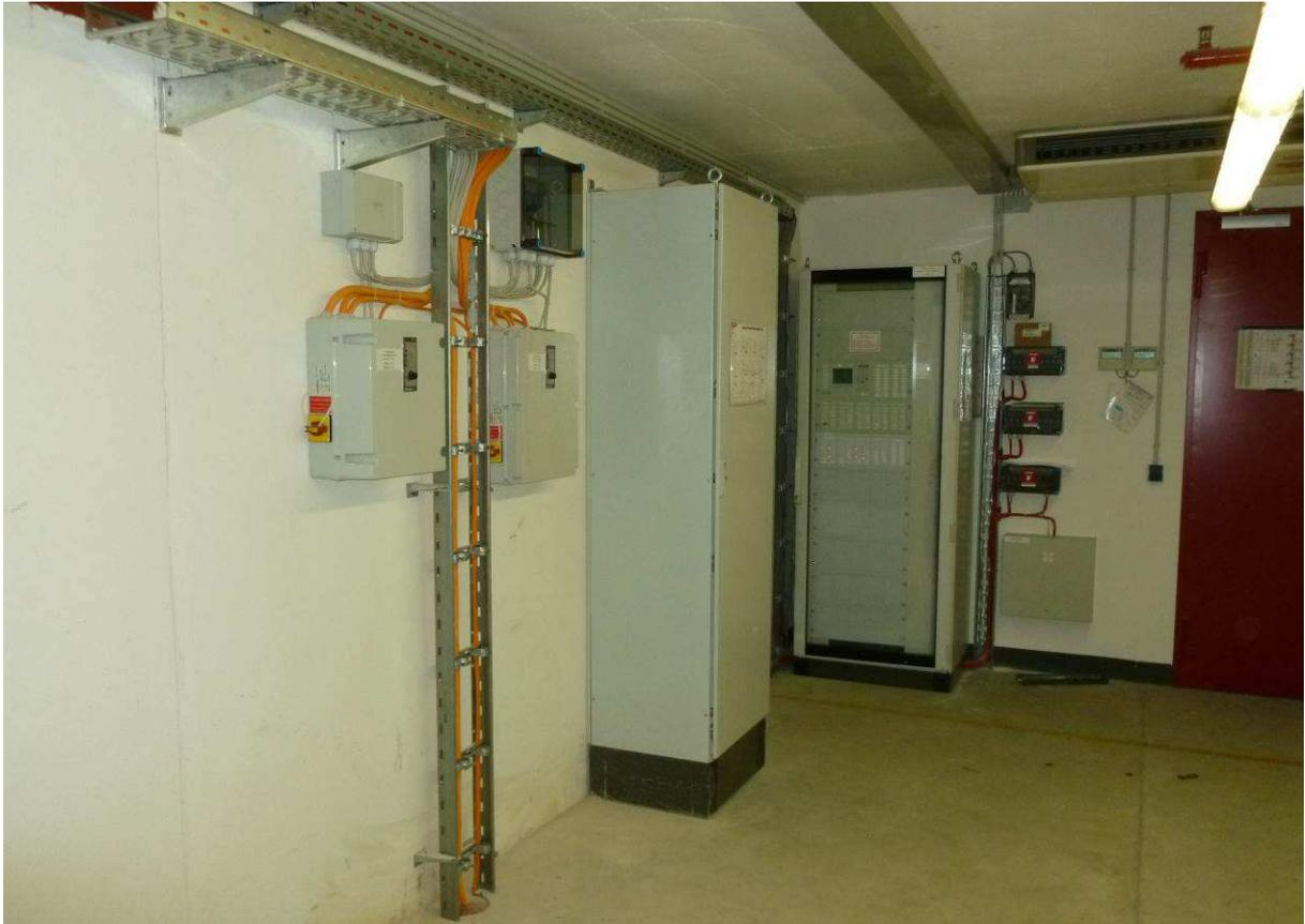
Abbildung 41 Funkenlöschanlage FLA 5 für den Bereich der Reststoffzentrale
