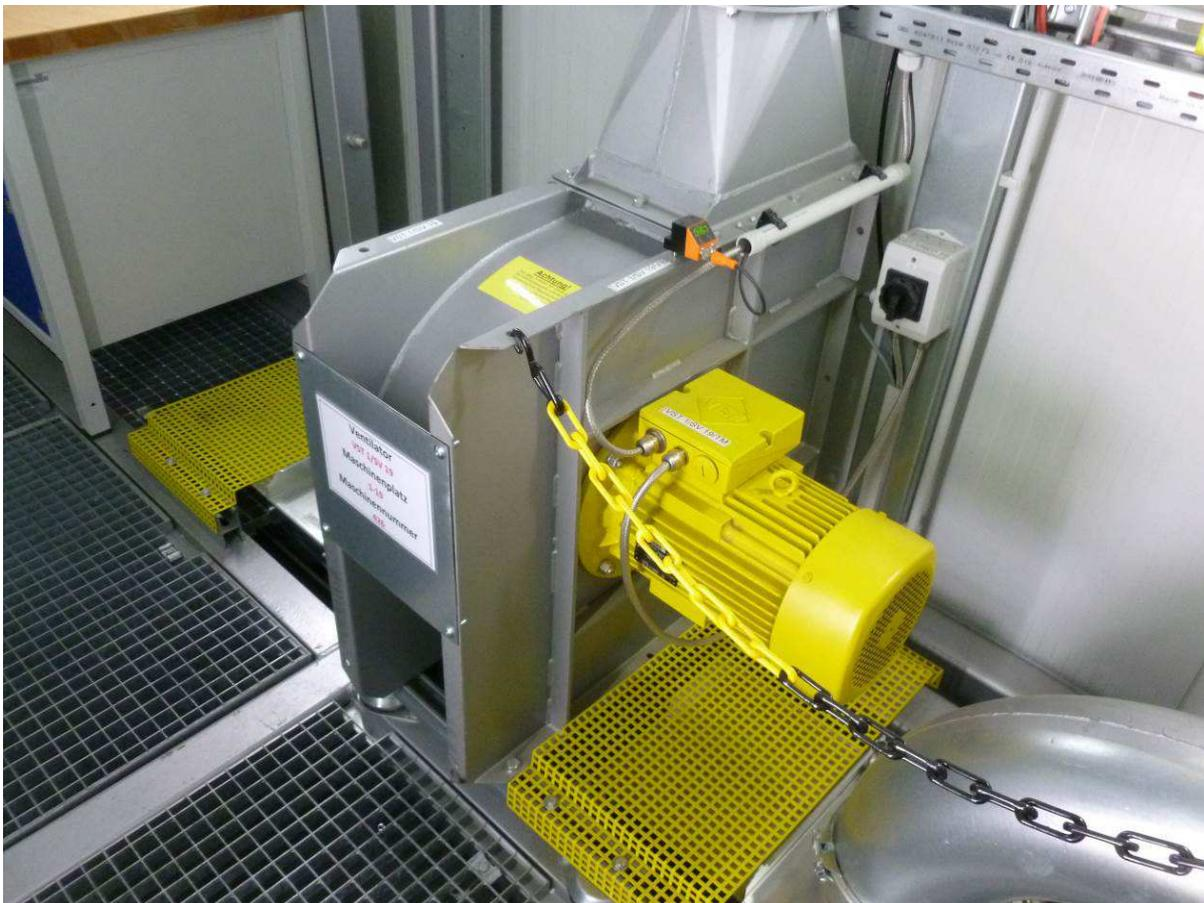
Abbildung 23 Stützventilator für WARO (hier nur einer von 42 Stück - je einer pro WARO)
