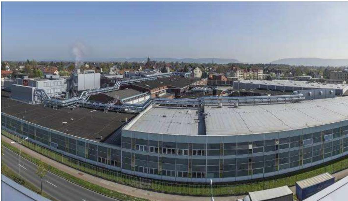
Abbildung 10 Hauptleitungsverlauf von Ventilatorenstation 1-2 über Dach PV
