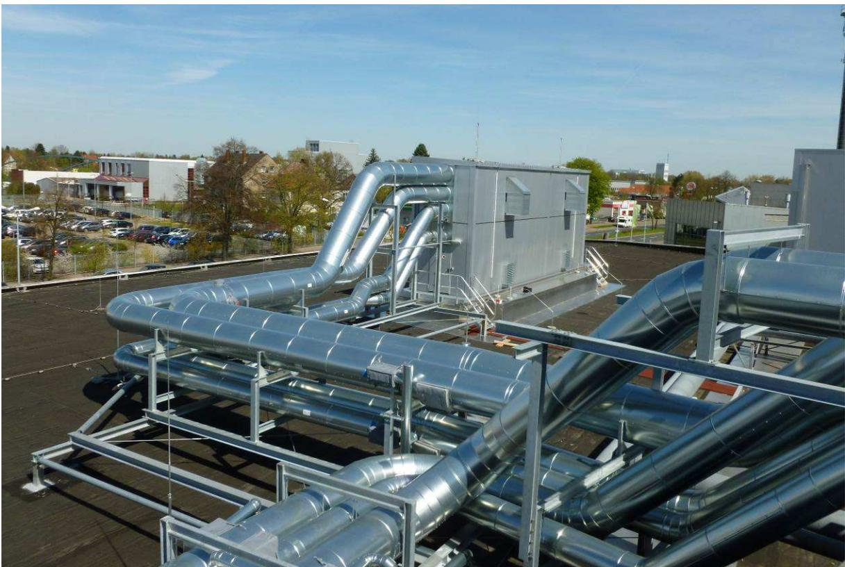
**Abbildung 21 Ventilatorenstation 1 mit Hauptleitungen Westansicht**
