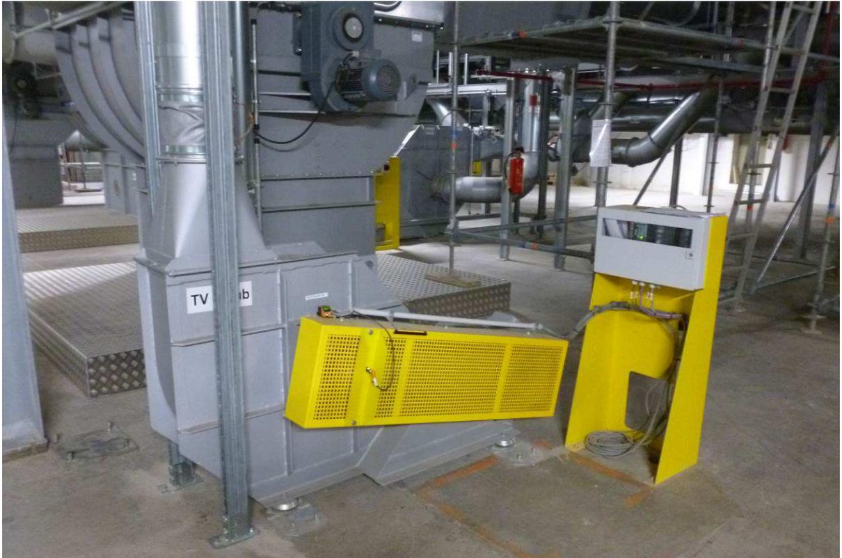
**Abbildung 37** Staubventilator für die Staubrückführung zu der Brikettpresse
