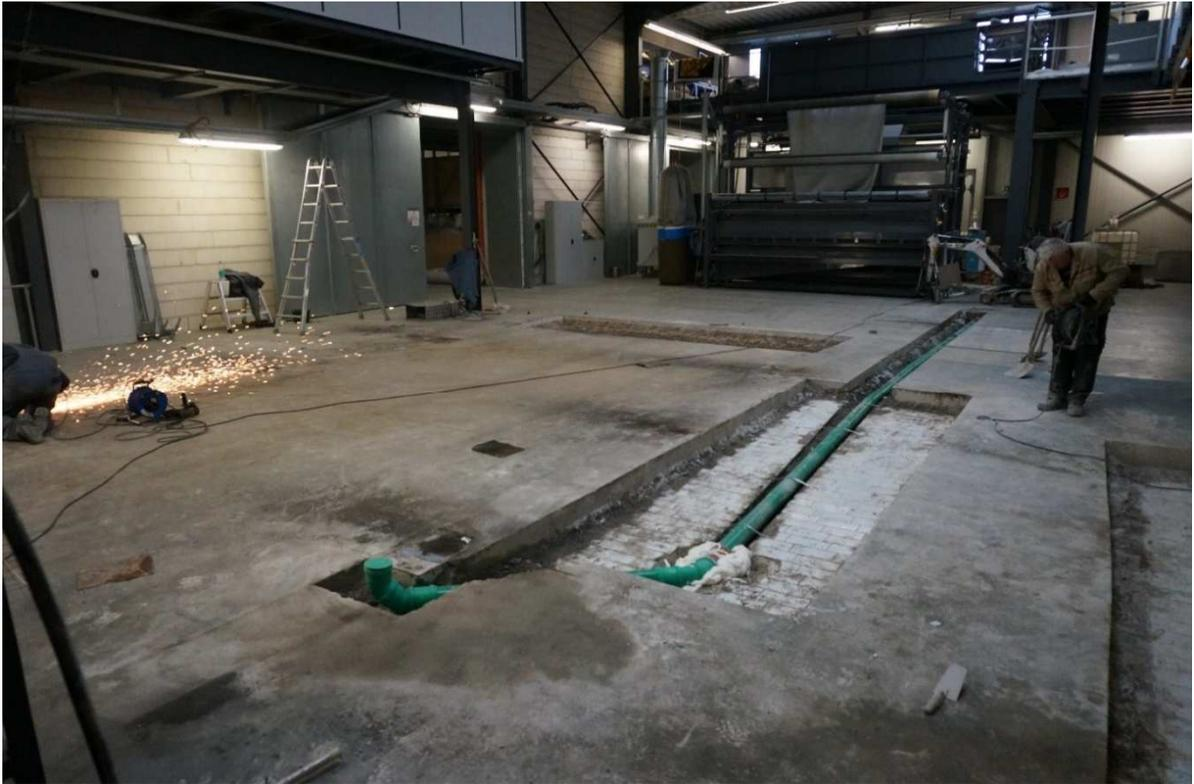
Abbildung 7: Verlegung der Ver- und Entsorgungsleitungen für die neue Teppichdruckanlage
