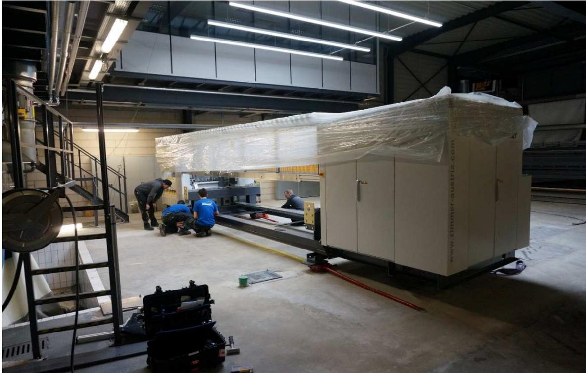
Abbildung 9: Positionierung der Druckkopfführung der neuen Teppichdruckanlage
