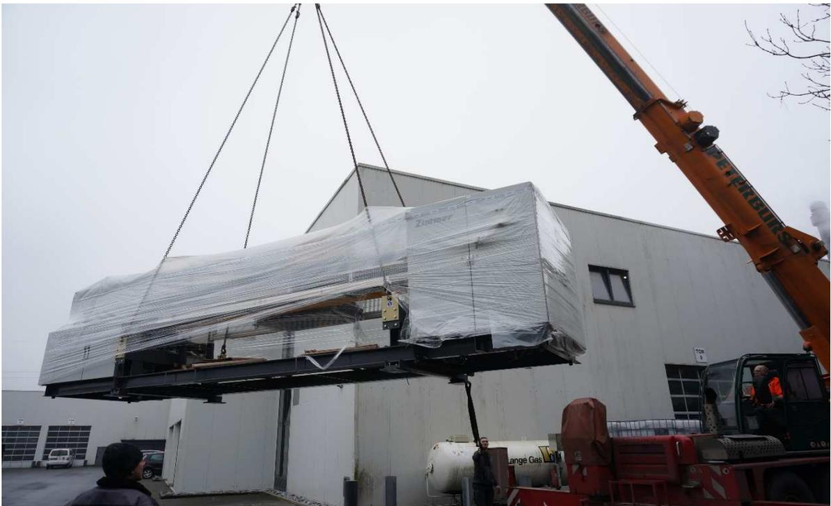
Abbildung 8: Abladen von vorgefertigten Komponenten der neuen Teppichdruckanlage
