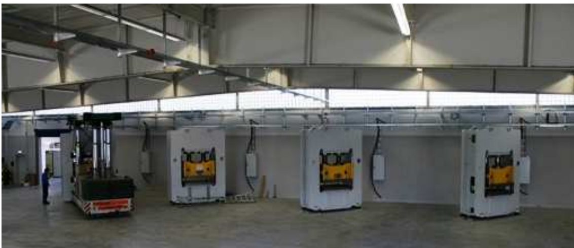
Abbildung 9: Montage der Oberdruckpressen mit einem Spezialkran
