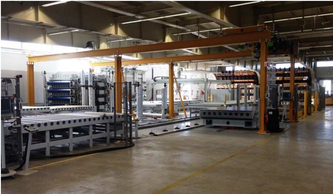
Abbildung 15: Montage des Bohr- und Beleimautomaten
