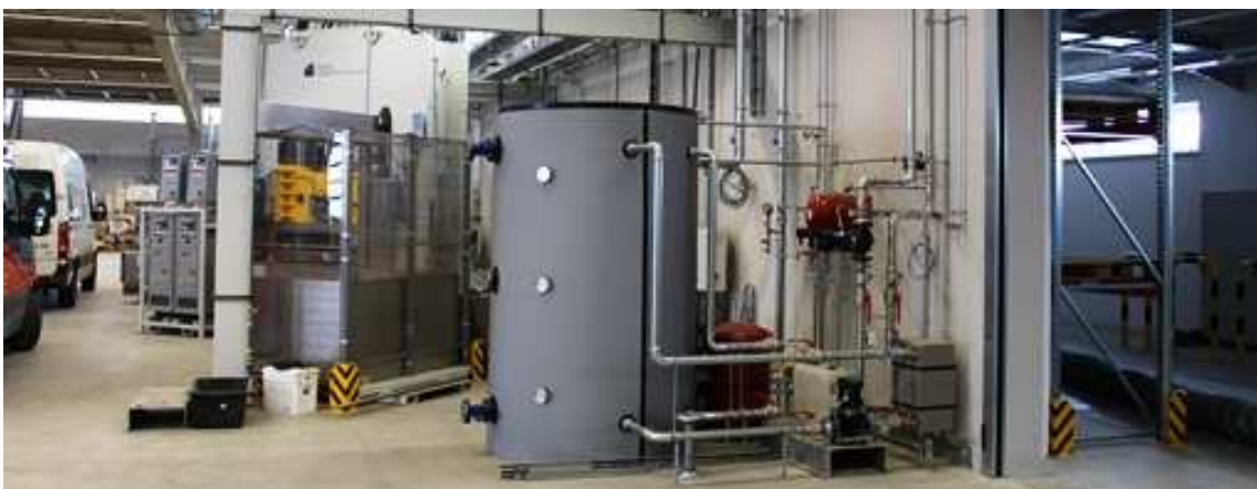
Abbildung 10: Montage des Kühlwasserkreislaufes der Oberdruckpressen
