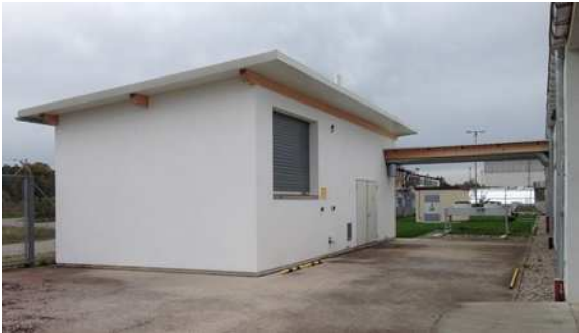
Abbildung 5: Heizzentrale mit Lagerraum für Festbrennstoffe
