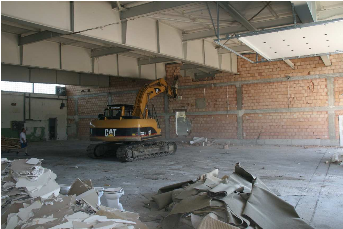
Abbildung 23: Blick in die Produktionshalle (aufgenommen am 07.06 2010)
