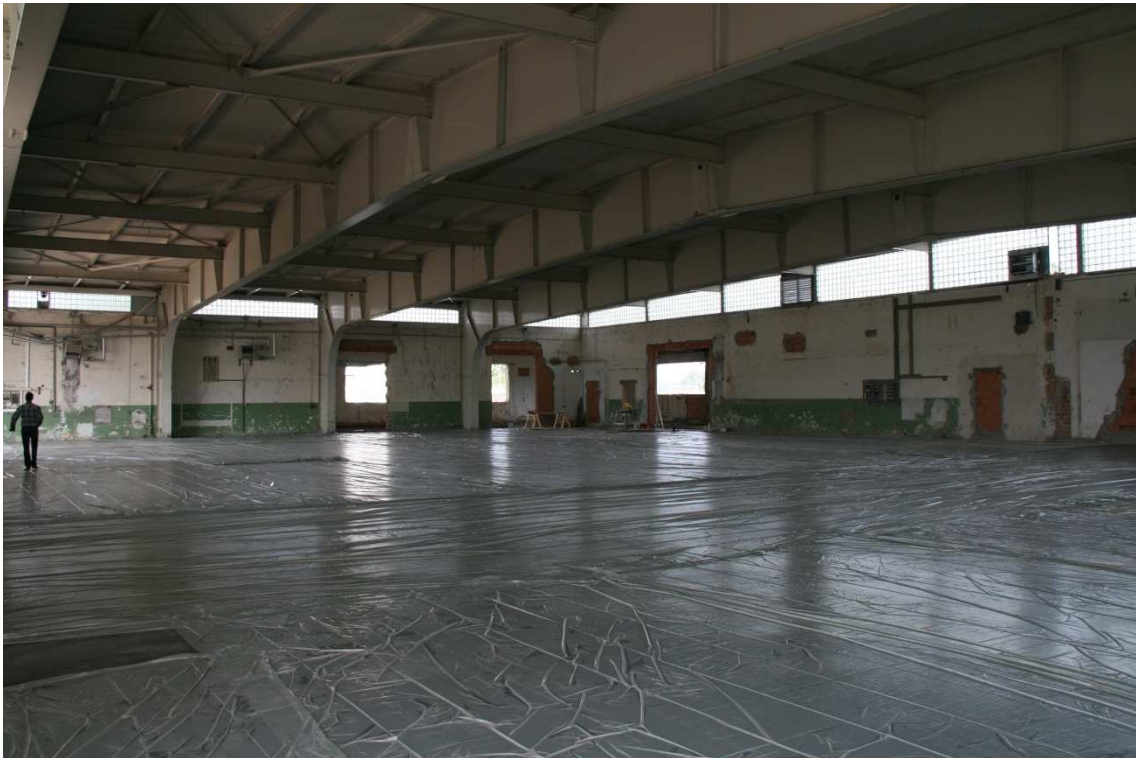
Abbildung 2: Produktionshalle im Rohbau mit neuer Bodenplatte
