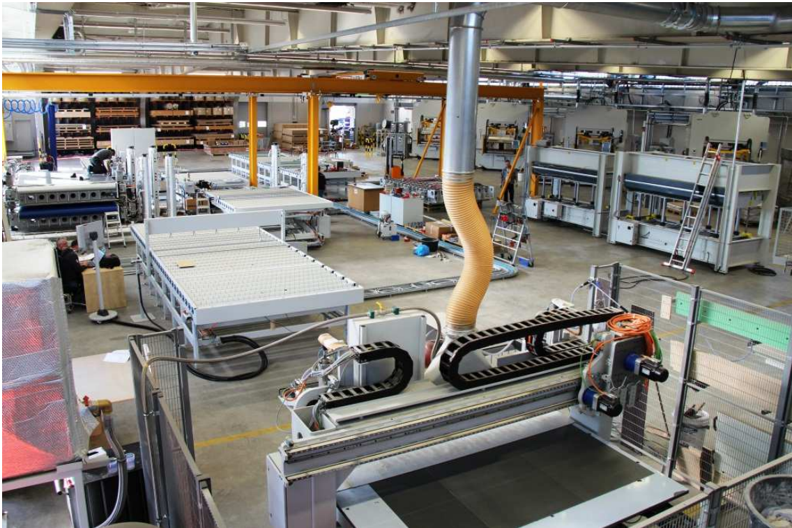
Abbildung 13: Inbetriebnahme der Scherenhubtische zur Beschickung der Flächenpresse
