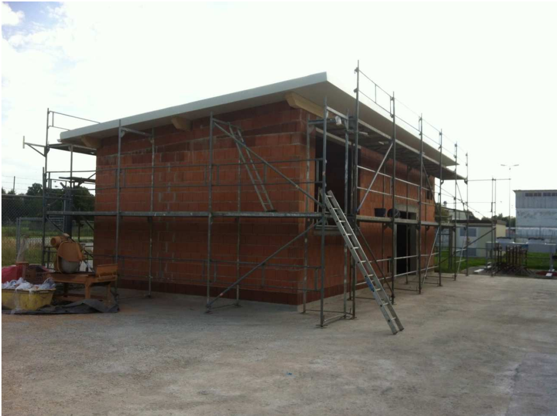
Abbildung 4: Rohbau der Heizzentrale
