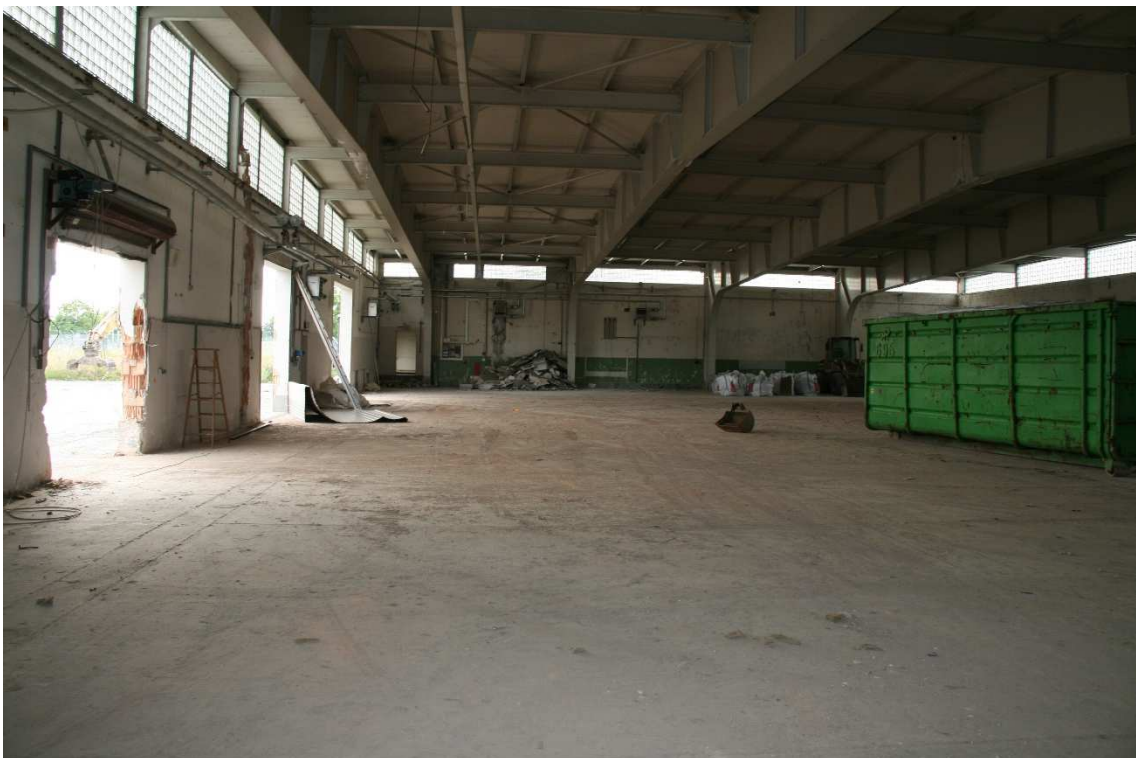
Abbildung 24: Blick in die Produktionshalle nach Entfernen der Innenwände
