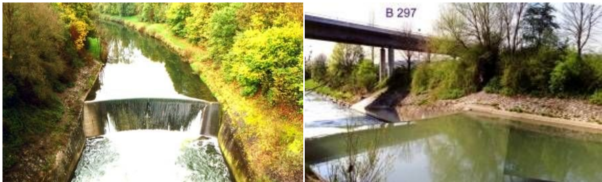
Abbildung 3: Stützschwelle in Faurndau / Fils
