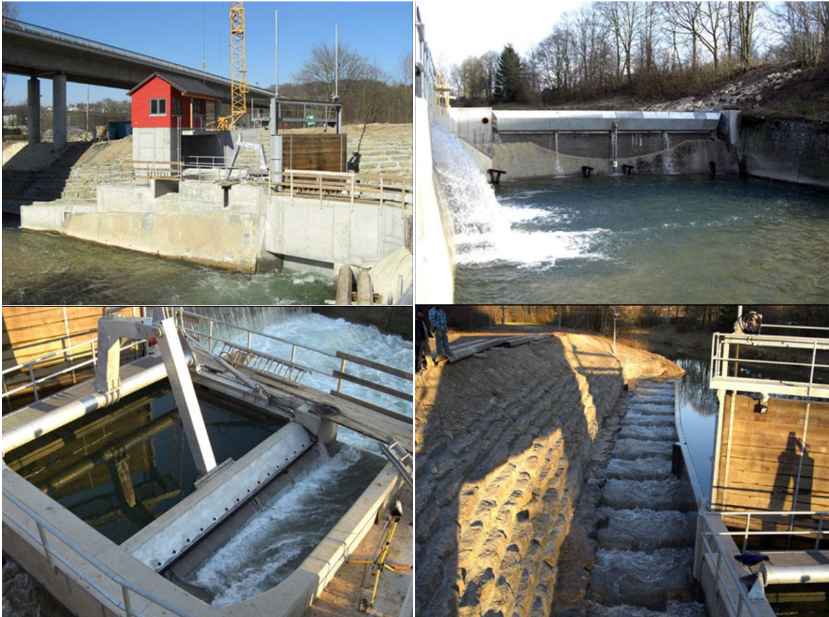
Abbildung 33: In Betrieb genommene Anlage
