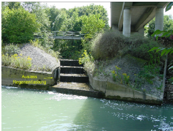
Abbildung 4: Einleitung des Brunnenbachs in die Fils wenige Meter unterhalb der derzeitigen Stützschwelle
