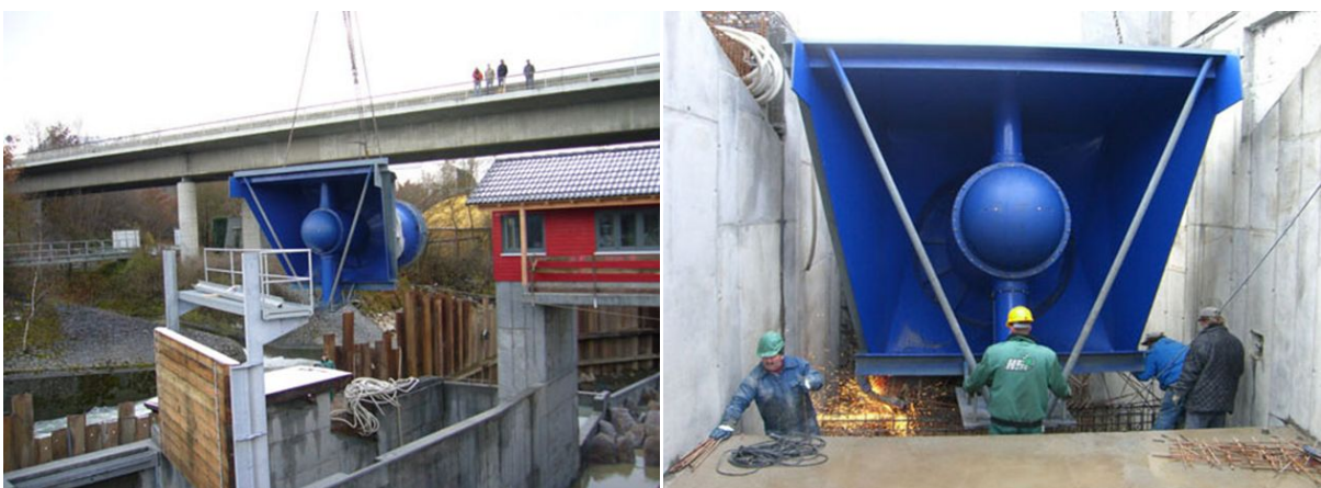
Abbildung 32: Installation der Turbine
