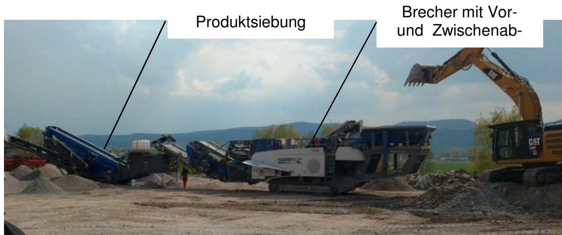
Bild 2: Gesamtansicht der Anlage mit Materialaufgabe, Brecher und Siebanlage
