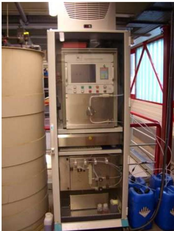
**Abb. 11: Kontinuierliche Überwachung der Elektrolytinhaltsstoffe mittels K-Alpha Onlinemessung (Foto: ABAG-itm)**
