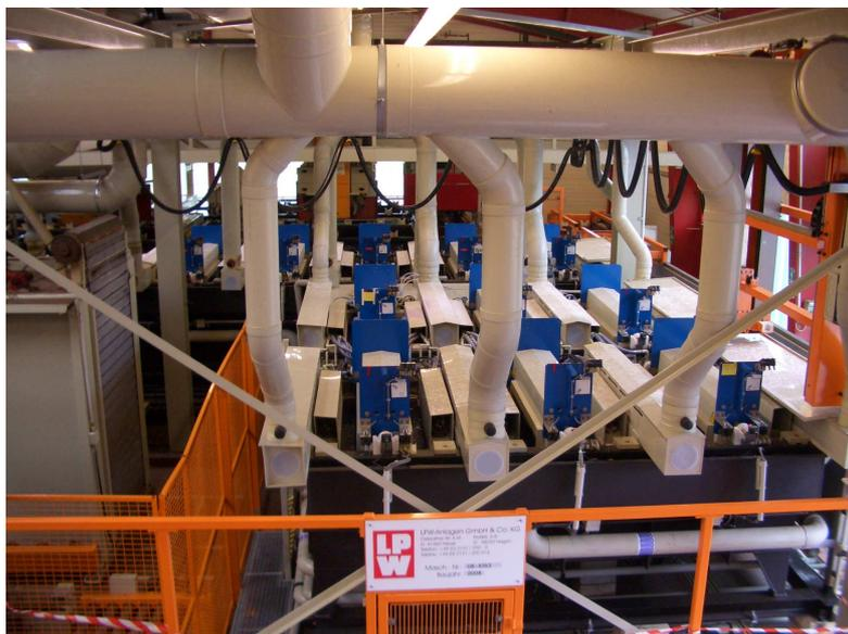
**Abb. 12: Absaugung oberhalb der Prozessbäder der Zn/Ni-Anlage (Foto: ABAG-itm)**
