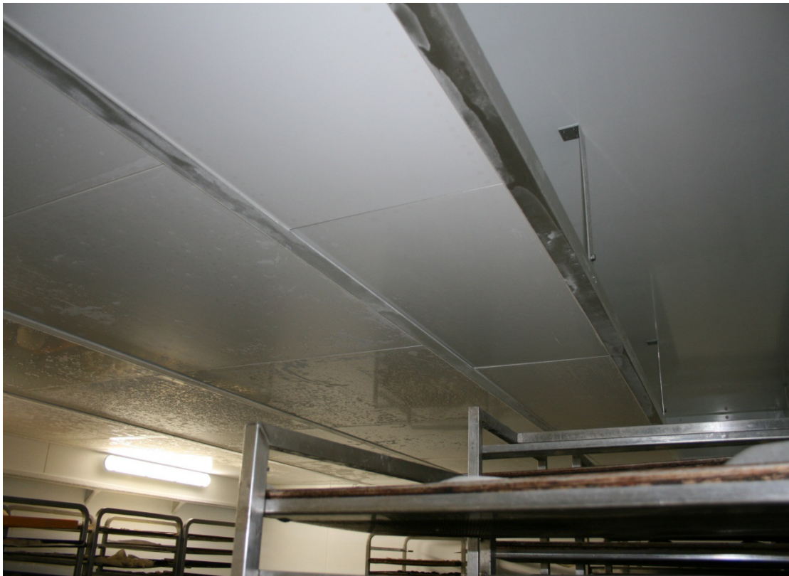
Abbildung 12: Montierte Zwischendecke inkl. Unterkonstruktion (Foto aus September 2013)
