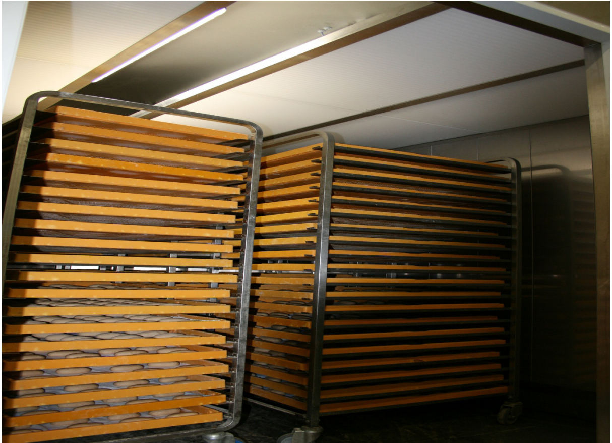
Abbildung 10: Montierte Zwischendecke inkl. Unterkonstruktion in einem Gärraum (Foto aus September 2013)
