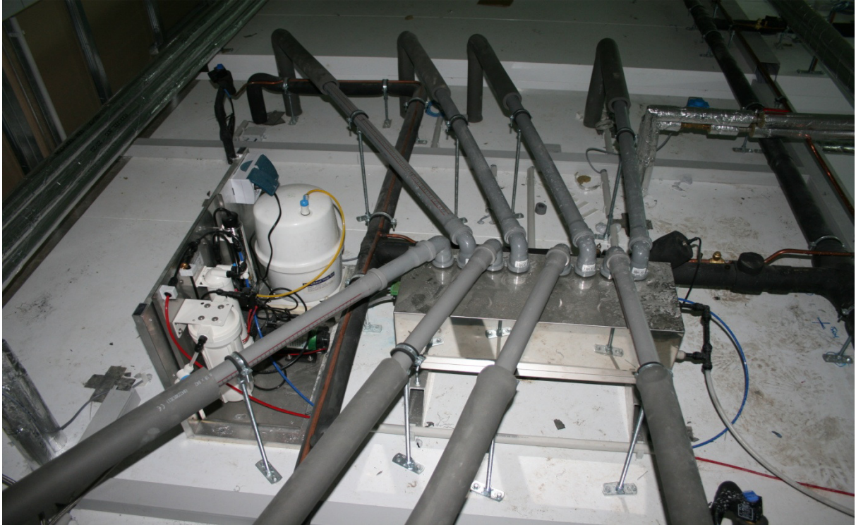
Abbildung 9: Die Micro-Befeuchtung ist auf dem Gärautomaten platziert und angeschlossen (Foto aus September 2013)
