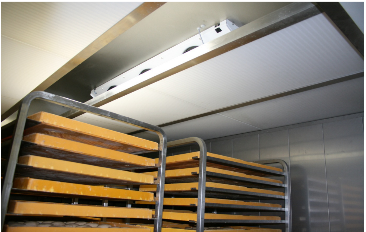
Abbildung 11: Montierte Zwischendecke inkl. Unterkonstruktion in einem Gärraum (Foto aus September 2013)
