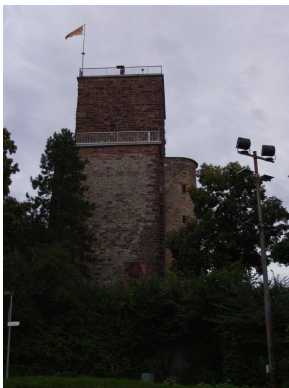
Die beiden Strahler auf den Turm gerichtet
