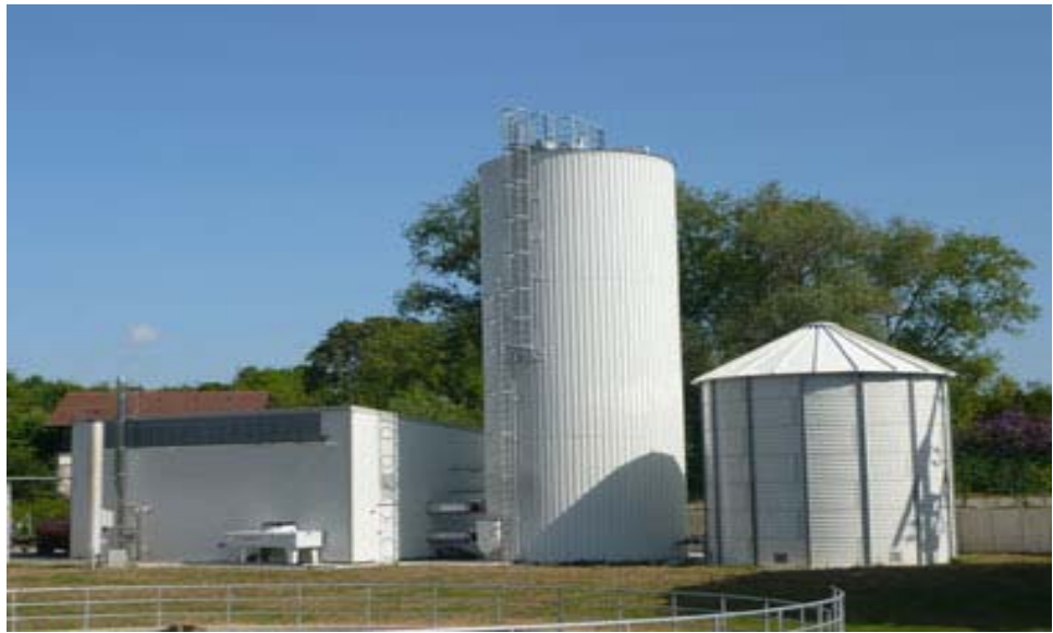
Abbildung 8: Hochlastfaulung der GKA Schozachtal: Betriebsgebäude, Hochlastfaulung, Biogasspeicher (von links nach rechts)
