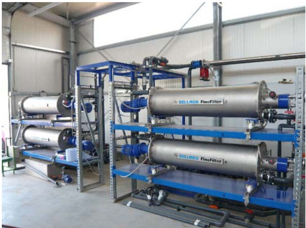
Abbildung 9: Vier parallel arbeitende Rotationsscheibenfilter im Betriebsgebäude
