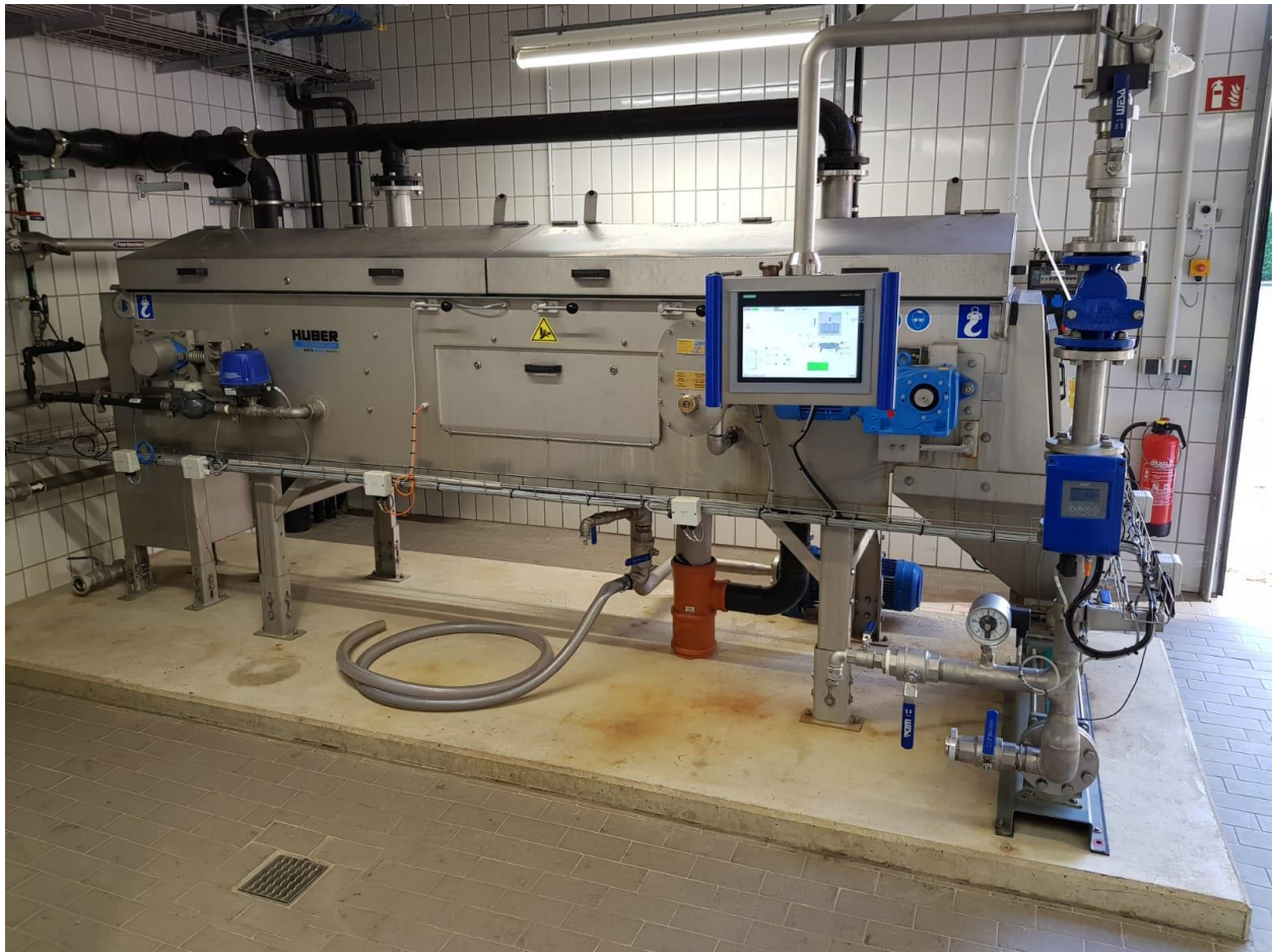
Abbildung 31: Mechanische Primärschlamm-Eindickung
