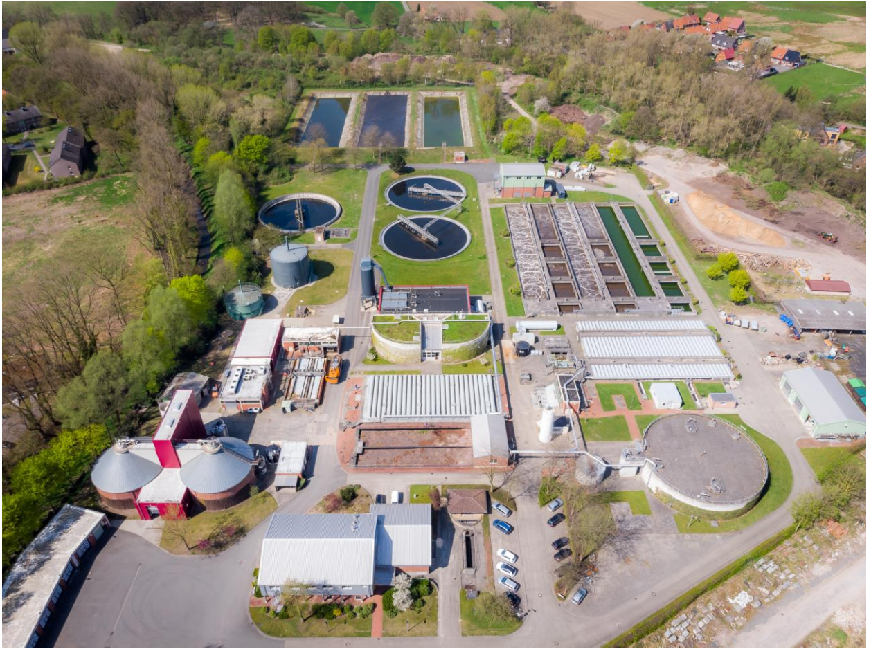
Abbildung 33: Luftaufnahme der KLA Lingen nach Umsetzung aller Maßnahmen
