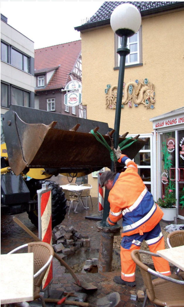
Abbau der alten Kugelleuchten | Quelle: Tiefbauamt Stadt Aalen
