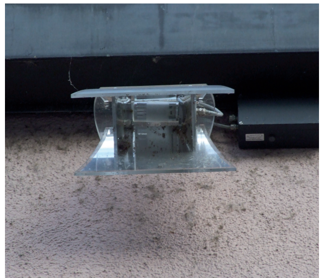
Unter dem Giebel angebrachter Flächenstrahler | Quelle: Tiefbauamt Stadt Aalen
