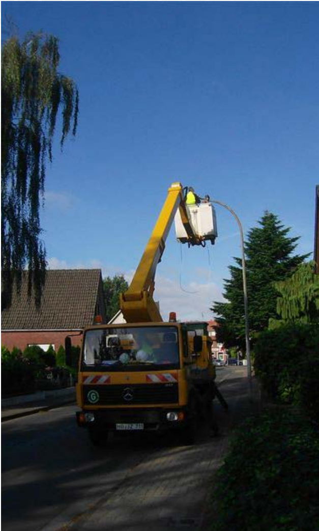
Abbau der alten ineffizienten Leuchten | Quelle: Gemeinde Goldenstedt
