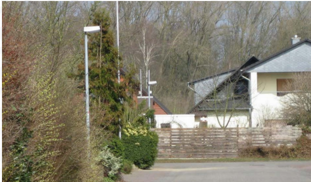
Alte Beleuchtungsanlage mit Quecksilberdampf-Hochdrucklampen | Quelle: Gemeinde Goldenstedt
