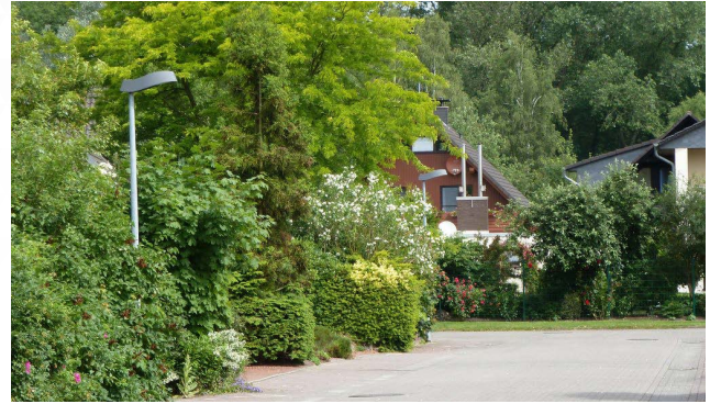
Beleuchtungsanlage mit dem neuen LED-System | Quelle: Gemeinde Goldenstedt
