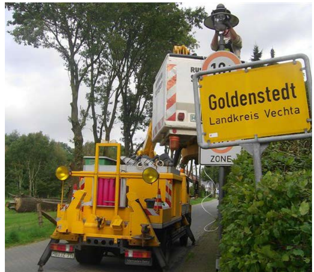
Umbauarbeiten in der Gemeinde Goldenstedt | Quelle: Gemeinde Goldenstedt
