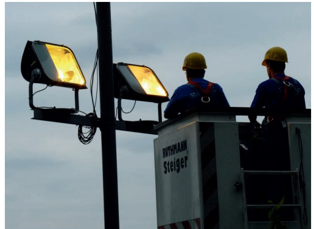
Demontage der alten Strahler | Quelle: Stadt Karlsruhe
