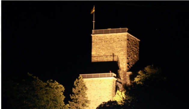
Die alte Turmbeleuchtung mit hoher Lichtemission Quelle: Stadt Karlsruhe
