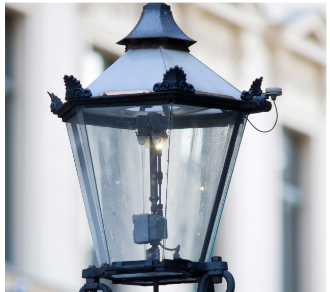
Die neuen LED-Leuchtmittel im Detail | Quelle: Stadt Leipzig
