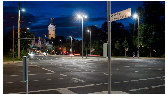
Neue, energiesparende Halogendampflampen | Quelle: Stadt Leipzig
