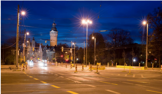
Alte Natriumdampf-Hochdrucklampen am Innenstadtring | Quelle: Stadt Leipzig
