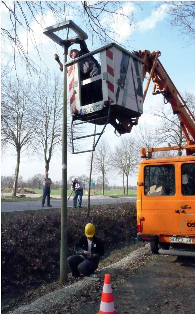
Montage- und Installationsarbeiten der neuen Beleuchtungsanlage Quelle: Stadt Lippstadt
