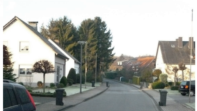
Neue LED-Straßenbeleuchtung | Quelle: Stadt Lippstadt
