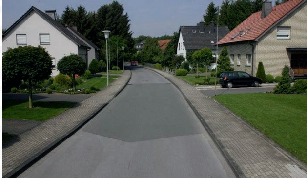
Alte Straßenbeleuchtung mit Quecksilberdampf-Hochdrucklampen Quelle: Stadt Lippstadt
