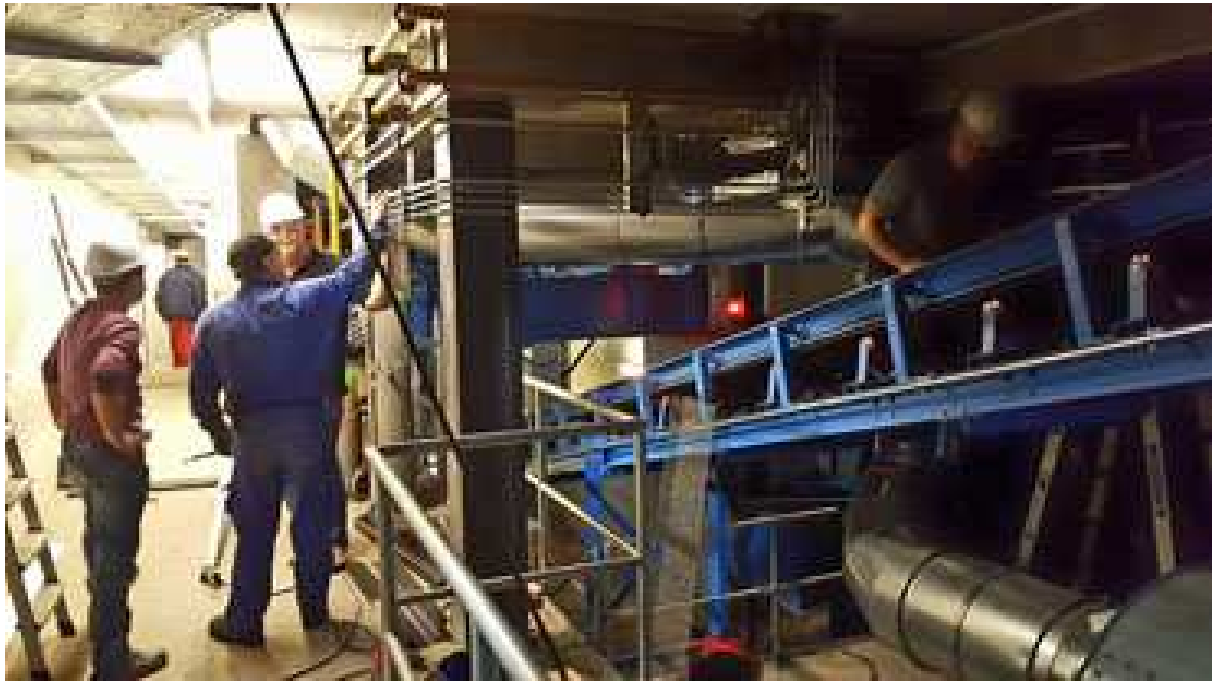
Abbildung 13: Blick auf die im Juli 2016 erfolgten Montagearbeiten im Unterflurbereich des Hochregallagers
