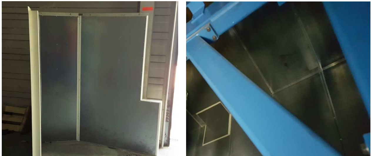
Abbildung 19: Schallschutzelement links: demontierbares Teil / rechts: fest installierte Schallschutzelemente
