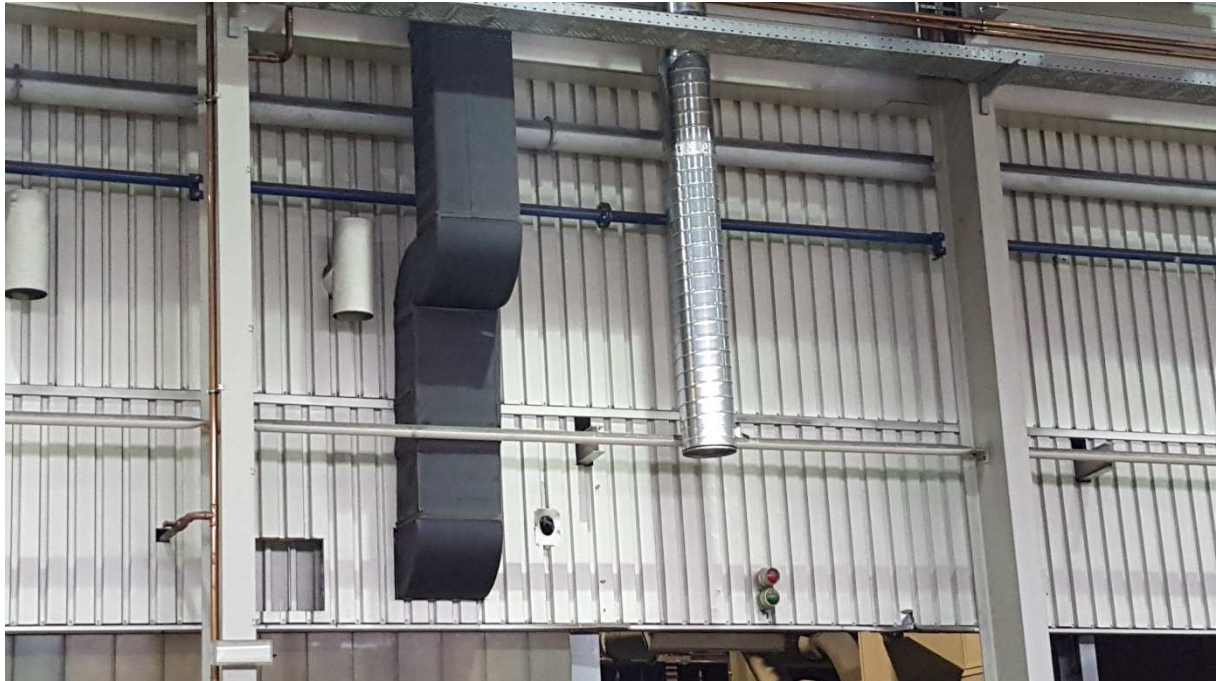
Abbildung 27: Vorgerüstete Leitungen für den Anschluss von Zu- und Abluftstellen | 02.02.2016
