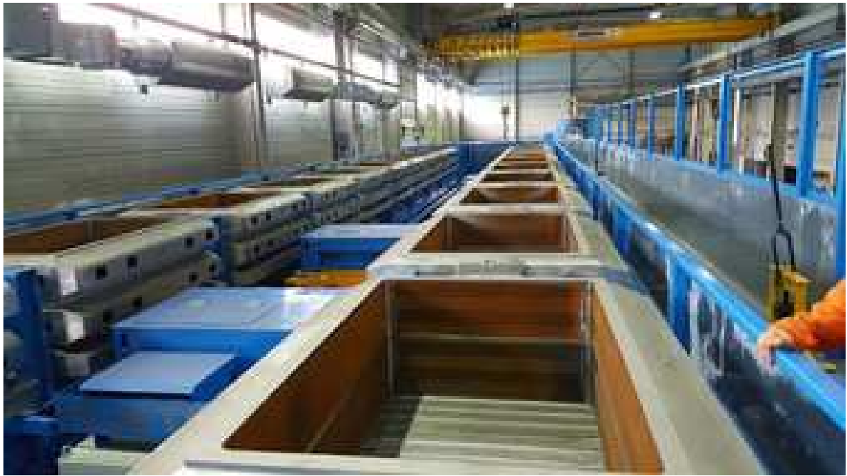
Abbildung 15: Blick auf die Gießlinie des Hochregallagers
