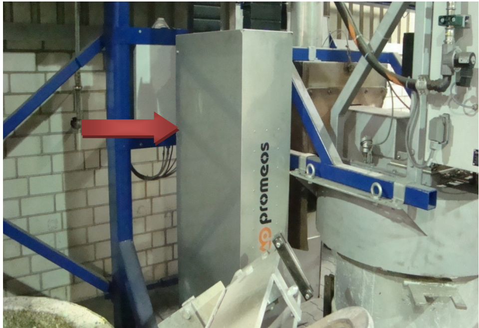
Abbildung 22: Anbau von „Kästen“ zum Hitzeschutz der Kabelschlepps
