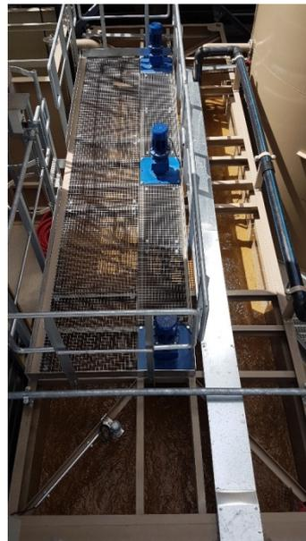
**Abbildung 19: Rührwerksbecken zur Schlammkonditionierung**
