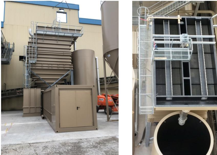
**Abbildung 12: Bei Stürmlinger eingesetzter 174 m<sup>3</sup>-Lamellenklärer**
