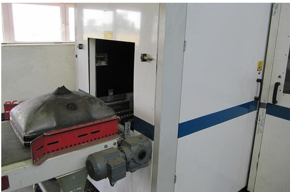
Abbildung 6: Eingangsschleuse der Lasertrennanlage
