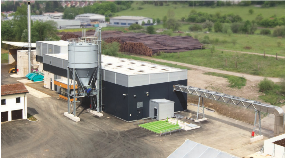
Abbildung 7 Ansicht der Anlage nach Inbetriebnahme
