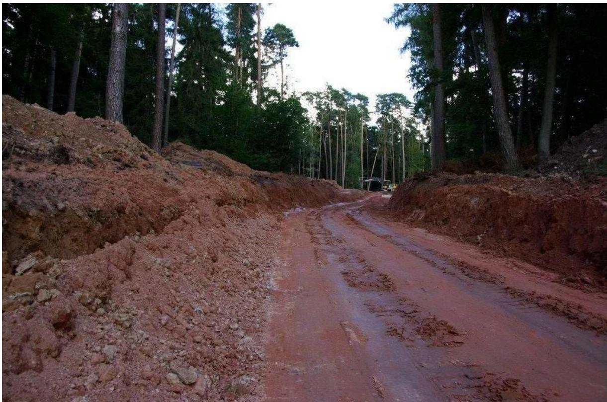
Abbildung 30: Erschließung einer Schwerlast-Straße für den Bau von Windkraftanlagen
