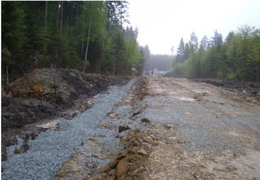
Abbildung 2: Baustraße zur Errichtung einer Windkraftanlage /iii/
