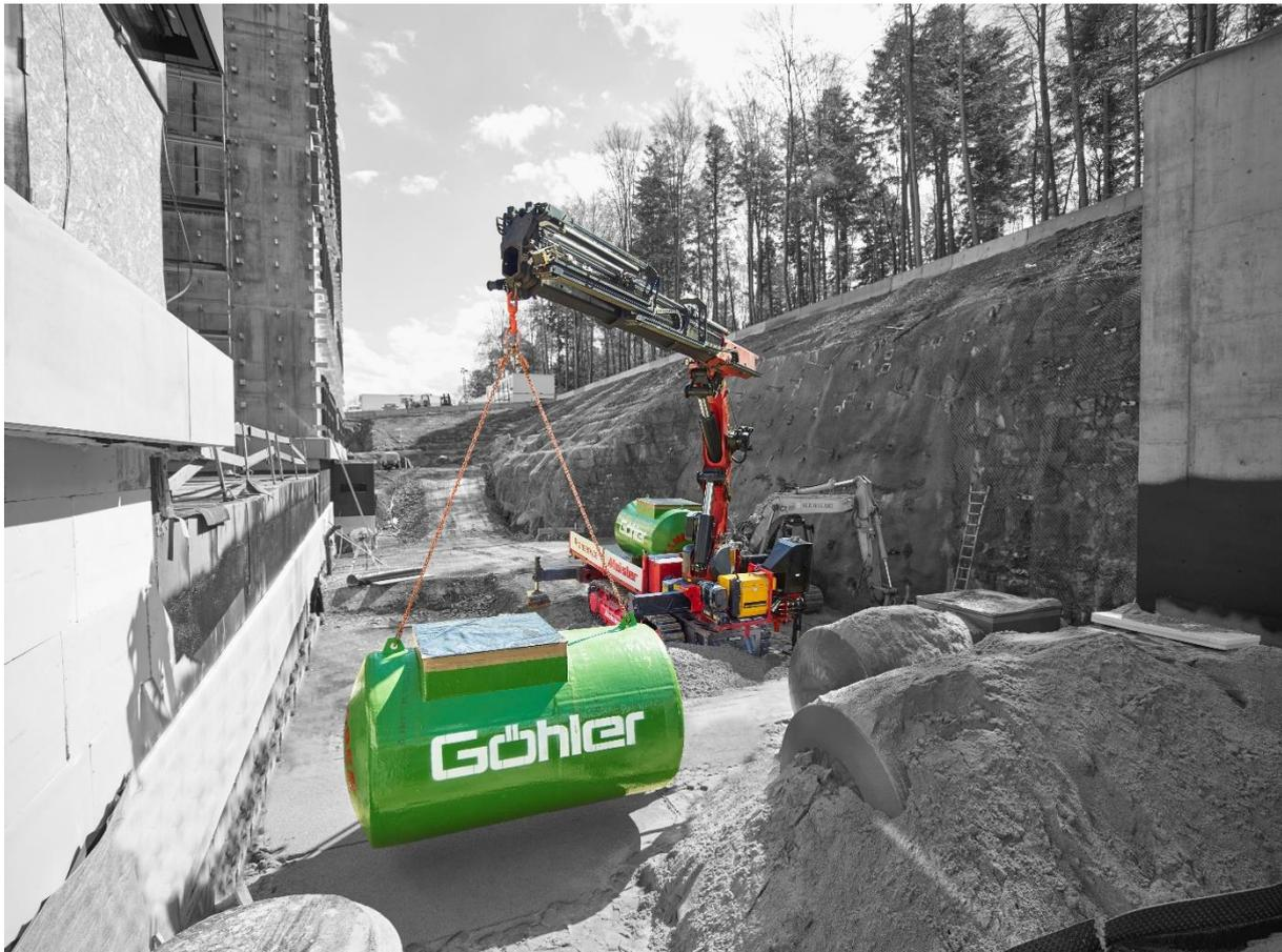
Abbildung 16: Transport und Hub im Betriebsmodus Offroad-Ladekran
