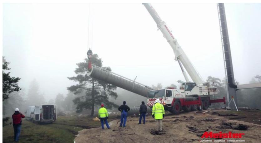
Abbildung 6: TC 50 Prototypstest zum Transport von Mastteilen auf einem steilen und mit Serpentina versehenen Waldweg und Errichtung mit einem konventionellen 100 t All-Terrain-Teleskop-Kranfahrzeug
