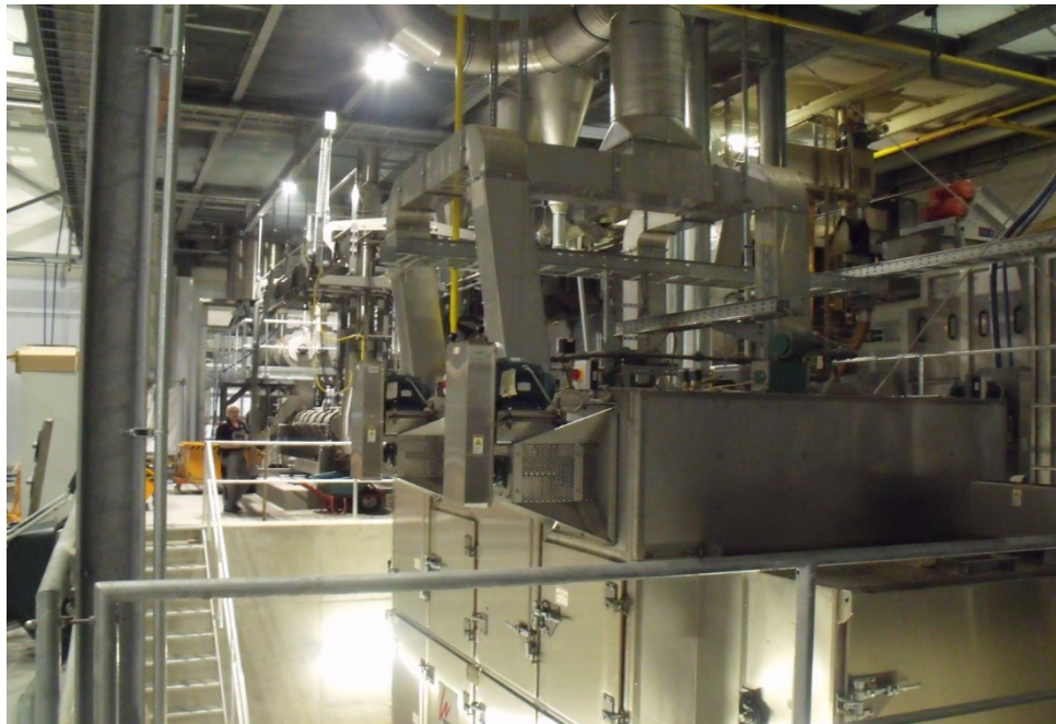
Abbildung 7: Vortrockner nach fertiger Installation im Probebetrieb, Foto vom 27.10.2015
