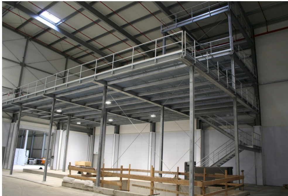
Abbildung 3: Aufstellungshalle neuer Extruder, Foto vom 28.03.2015
