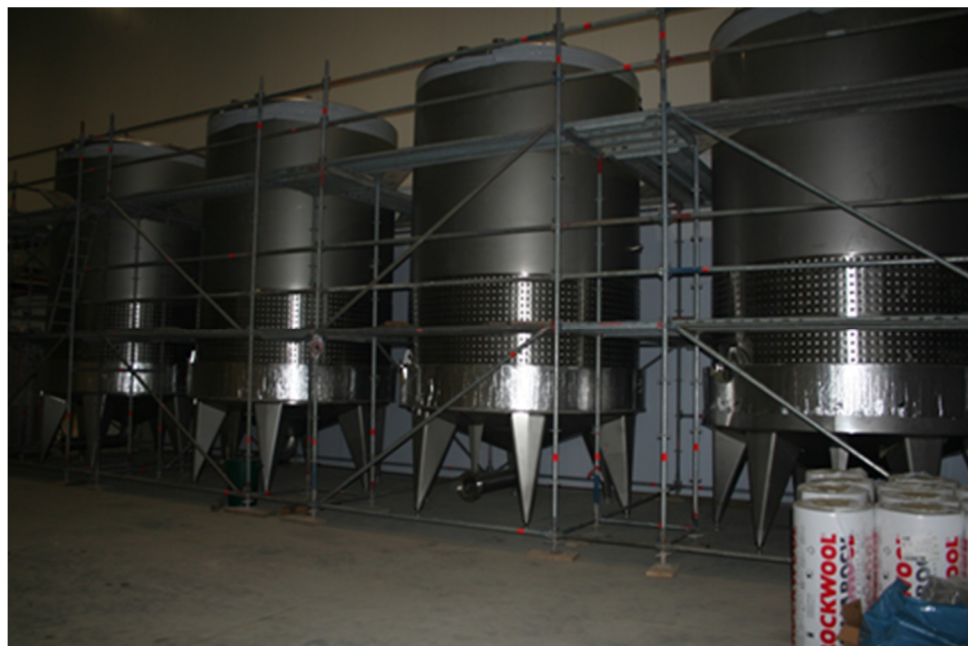
Abbildung 4: Frischfleischtanks während der Isolierarbeiten, Foto vom 07.04.2015
