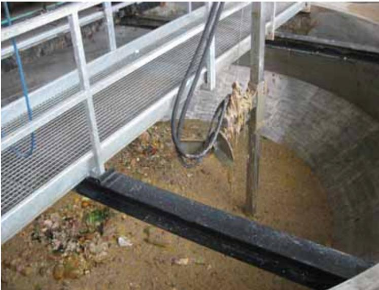
Bild 3: Anmischbehälter mit Rührwerk
