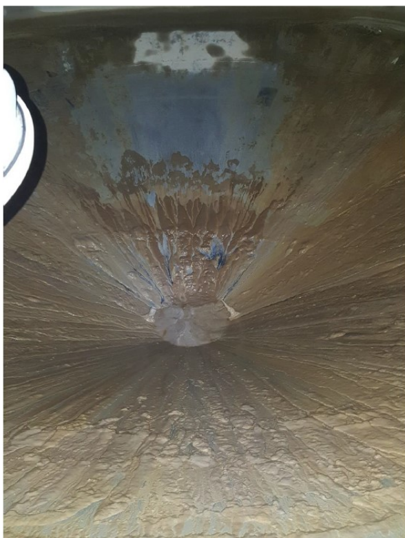
Abbildung 37: Sedimente Tank Laugenwässer
