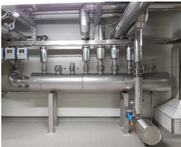
Abbildung 8: Sammler/Verteiler W60-System
