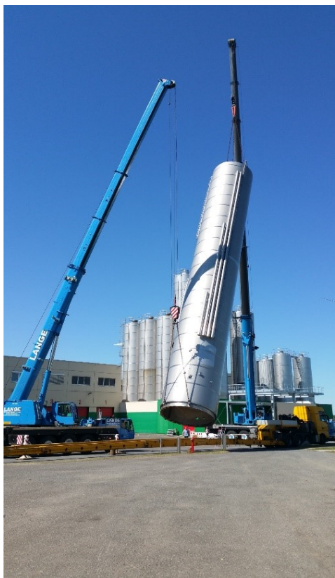
Abbildung 4: Aufstellung Puffertank W40
