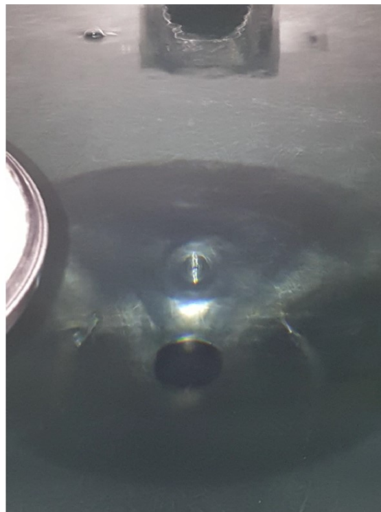
Abbildung 39: Sedimente Tank Brüdenkondensate
