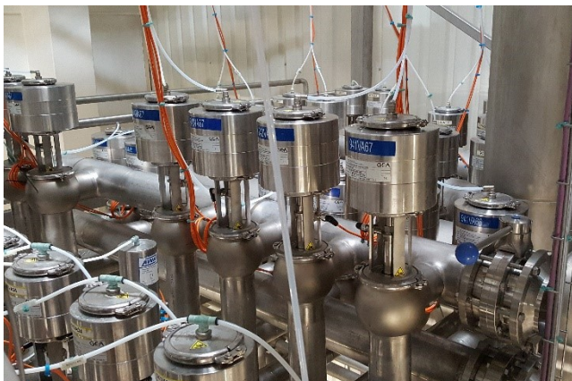
Abbildung 13: Umschaltventile an CIP-Anlage
