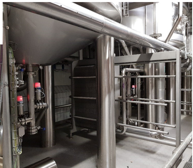
Abbildung 14: Tanks mit Spitzkegelboden
