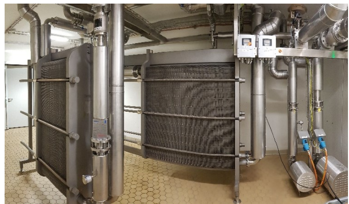
Abbildung 9: Übergabewärmetauscher W60
